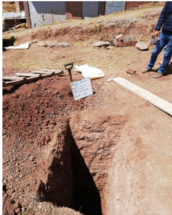
Figura 42. Excavación de la calicata
