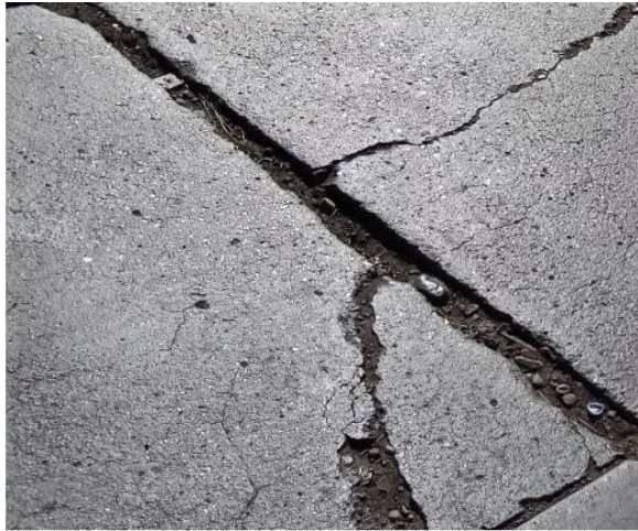
Figura 3 Losa dividida.
