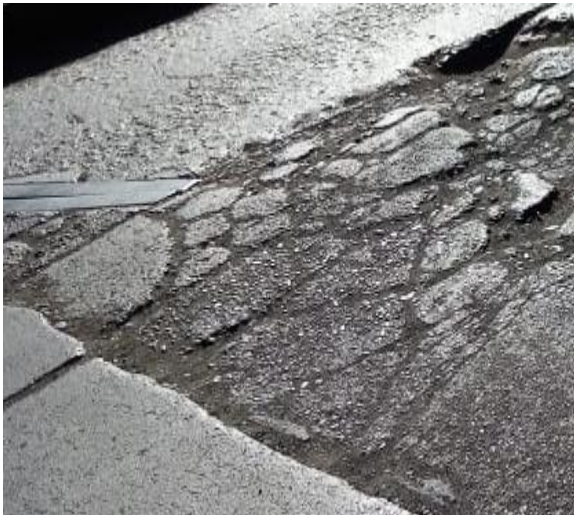
Figura 10 Descascaramiento de esquina.
