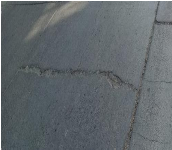
Figura 5 Grieta lineal.
