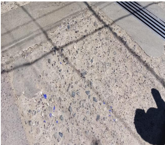
Figura 10 Descascaramiento de esquina.
