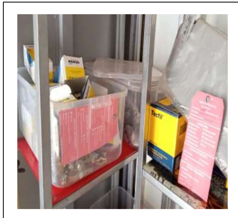
Figura 28 Zona de Almacén desordenada - repuestos eléctricos
