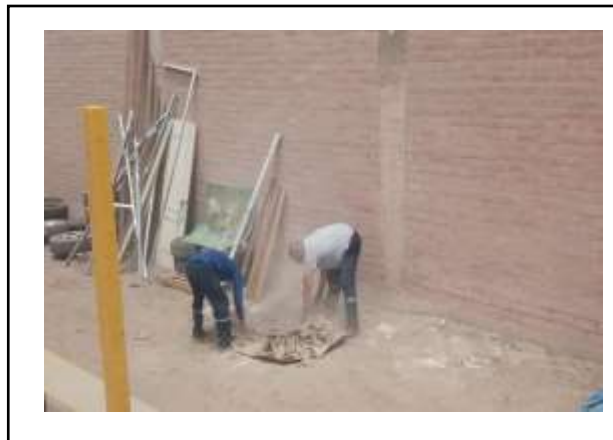
Figura 40 Limpieza de área de mantenimiento
