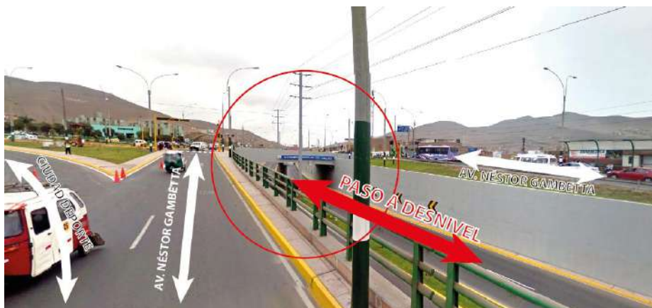
By pass Av. Nestor Gambetta, Zona urbanización satélite.
