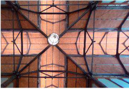
Estructura de cubierta realizada en tijerales y con tejas dejando elevación central para la ventilación e iluminación indirecta.
