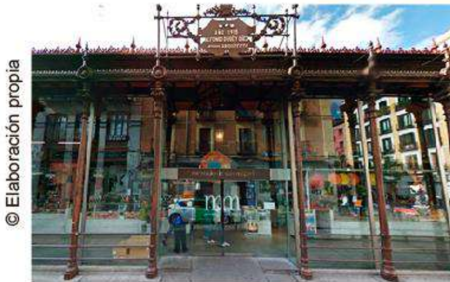
Fachada que expone el cerramiento y los vitrales para la iluminación natural.
