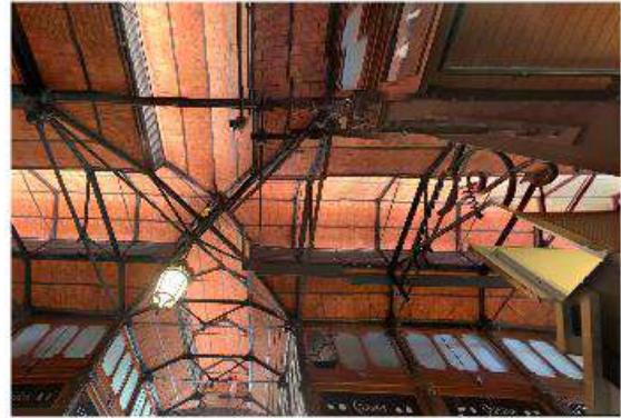
Estructura de cubierta realizada en tijerales y con tejas dejando elevación central para la ventilación e iluminación indirecta.
