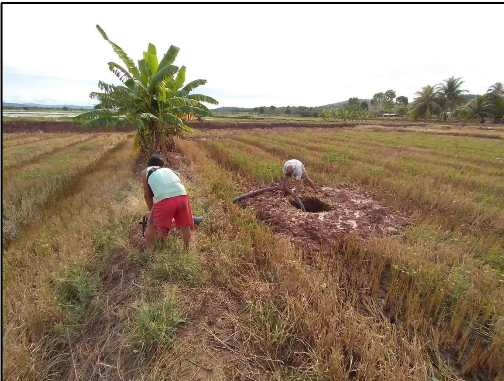
Foto 8: Limpieza de calicata para extracción de material de muestra.
