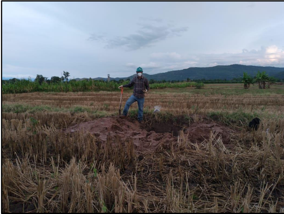
Foto 5: Preparación de la calicata.
