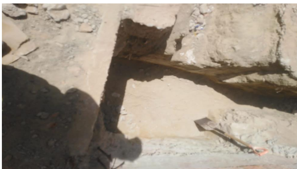
figura 16.escavacion para estudio de suelos
