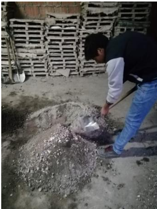
Mezclado del concreto patrón previo diseño de mezcla
