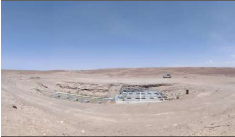
Vista panorámica de la planta de tratamiento (tratamiento primario)
