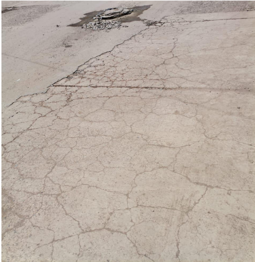
Fotografía N° 16. PUNZONAMIENTO / LOSA DIVIDIDA
