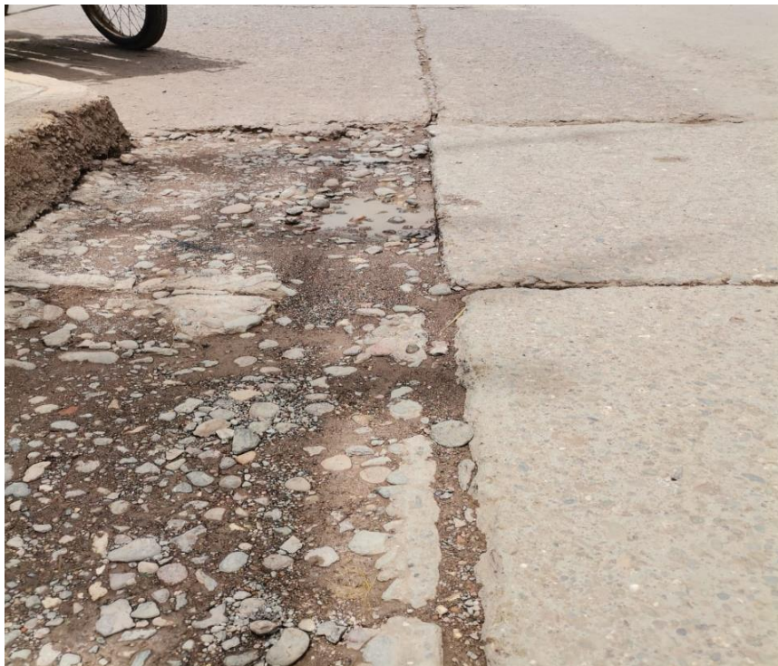
Fotografía N° 14. ESCALA / PULIMIENTO DE AGREGADOS
