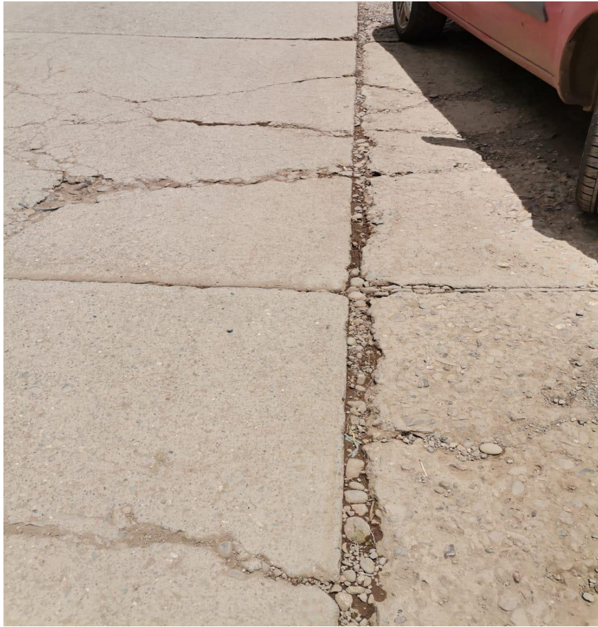
Fotografía N° 12. GRIETAS DE ESQUINA / DESCASCARAMIENTO DE ESQUINA
