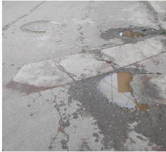
Fotografía N° 05 y 06. PARCHES / AGRIETAMIENTO
