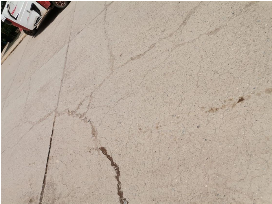
Fotografía N° 16. PUNZONAMIENTO / LOSA DIVIDIDA
