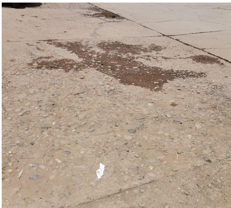
Fotografía N° 18. PULIMIENTO DE AGREGADOS
