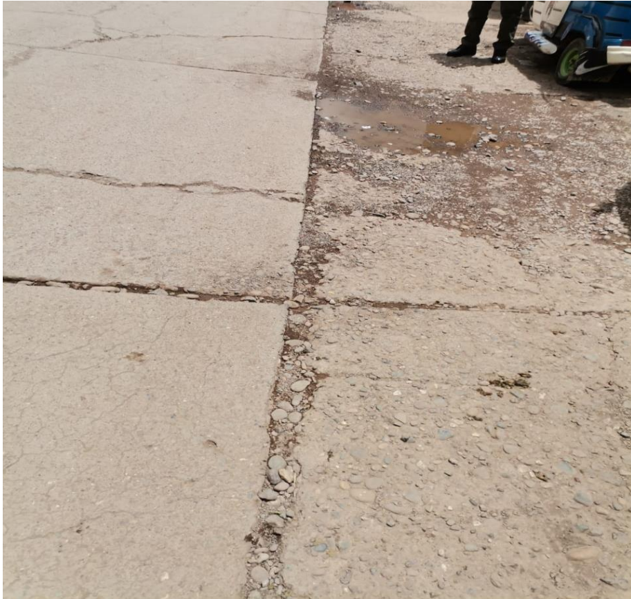
Fotografía N° 14. ESCALA / PULIMIENTO DE AGREGADOS
