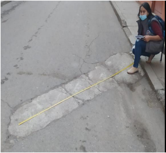
Fotografía N° 05 y 06. PARCHES / AGRIETAMIENTO
