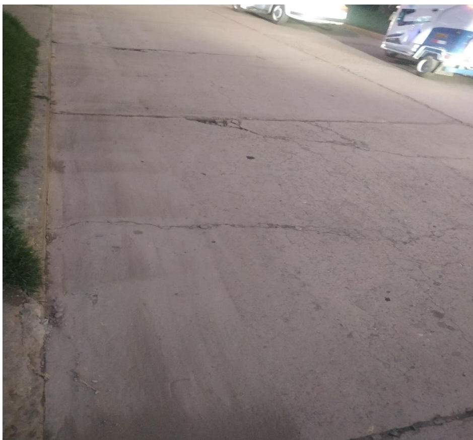
Fotografía N° 17. GRIETAS LINEALES
