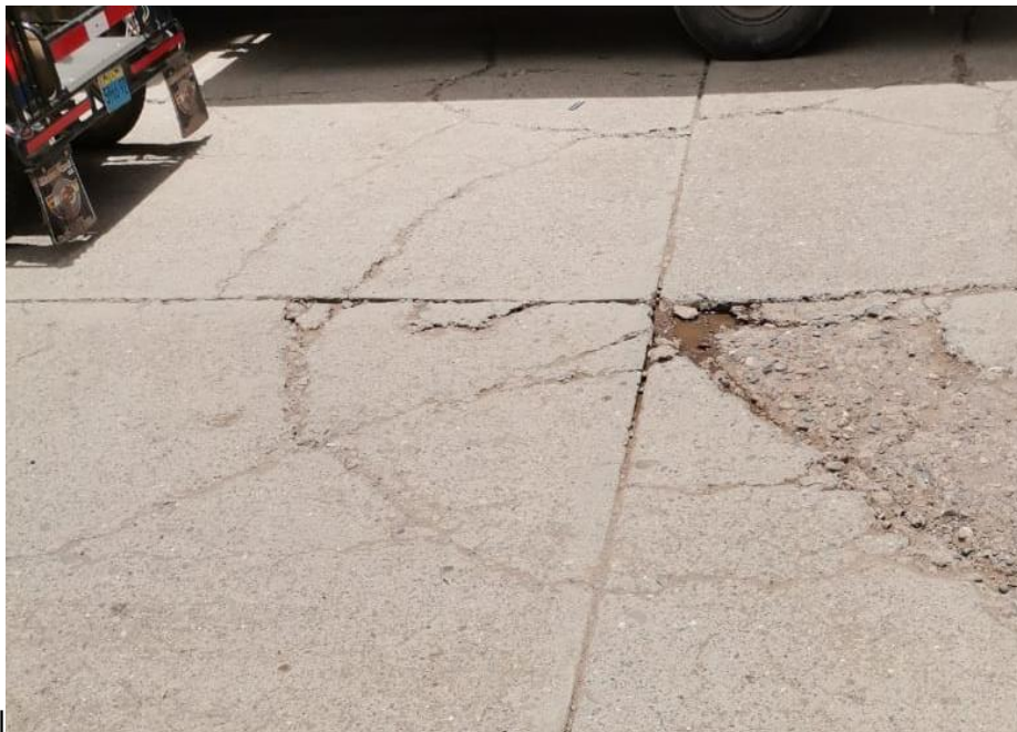
Fotografía N° 12. GRIETAS DE ESQUINA / DESCASCARAMIENTO DE ESQUINA
