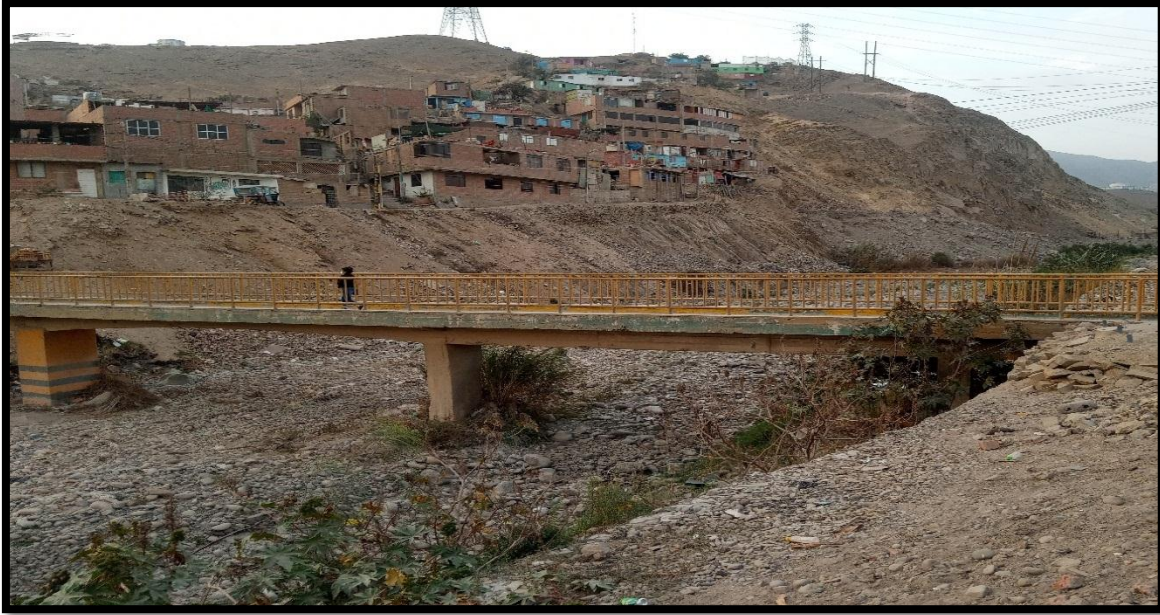
Figura 30. Zona de Estudio de inicio Puente Nueva Esperanza tramo 0+000 Km.
