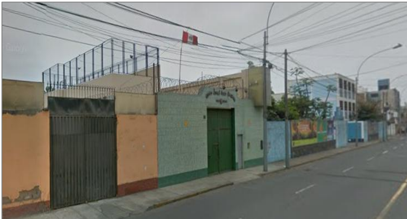
FOTOGRAFÍA N°1: EDIFICACIONES CERCANAS AL CENTRO JUVENIL
