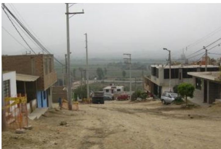
Instalación de Energía Eléctrica
