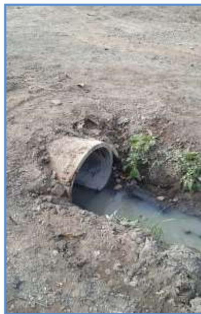
Fuente: Propia. En la foto observamos que las aguas servidas se conducen por canales que no se encuentran cubiertos, generando un foco de contaminación.
