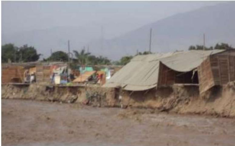
Viviendas colapsadas e inhabitables debido a la erosión de la ladera de la margen izquierda del río Chillón. (CISMID, 2017).
