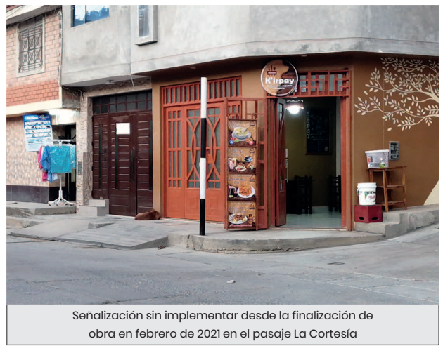
Señalización sin implementar desde la finalización de obra en febrero de 2021 en el pasaje La Cortesía
