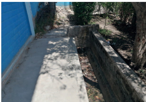
Cerramiento de concreto que rodea el alcantarillado fluvial a la par de una vereda de acceso
