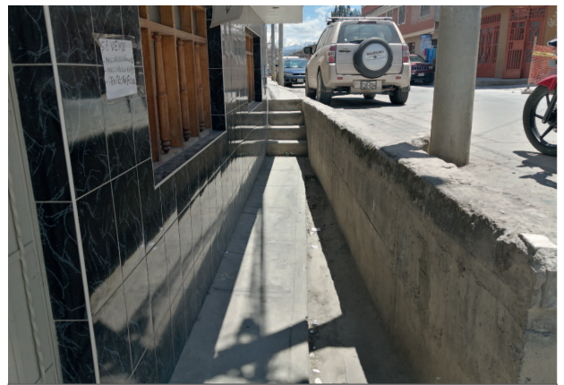
Extensión de vereda en depresión por la ubicación del ingreso hacia el predio
