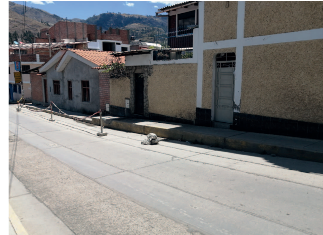
Cercos erigidos por los vecinos del pasaje Sarita Colonia en respuesta a la falta de seguimiento hacia la señalización y excesivo estacionamiento
