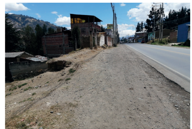
Sendero de tierra afirmada que conecta con un predio deprimido en la avenida Centenario
