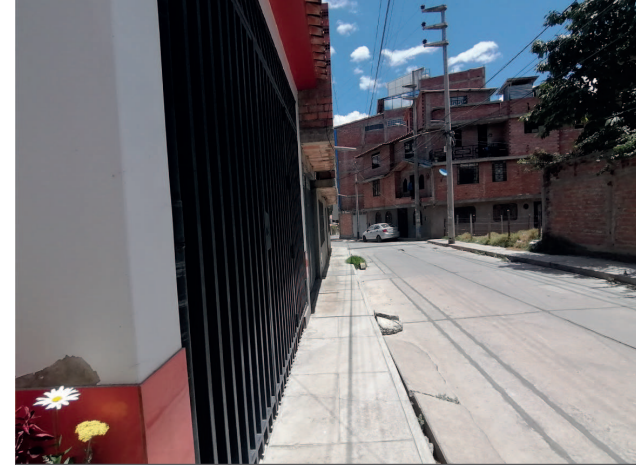
Veredas en el pasaje La Colina con rampas de acceso vehicular
