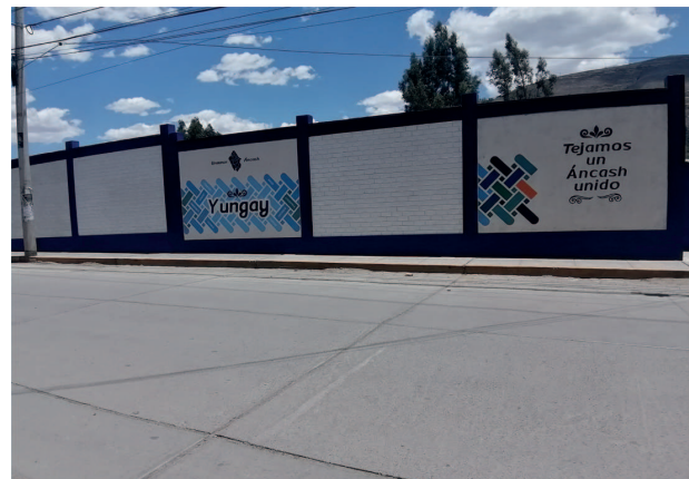
Pista en el tramo entre la Plazuela de Vichay y el Gobierno Regional con bermas a los lados
