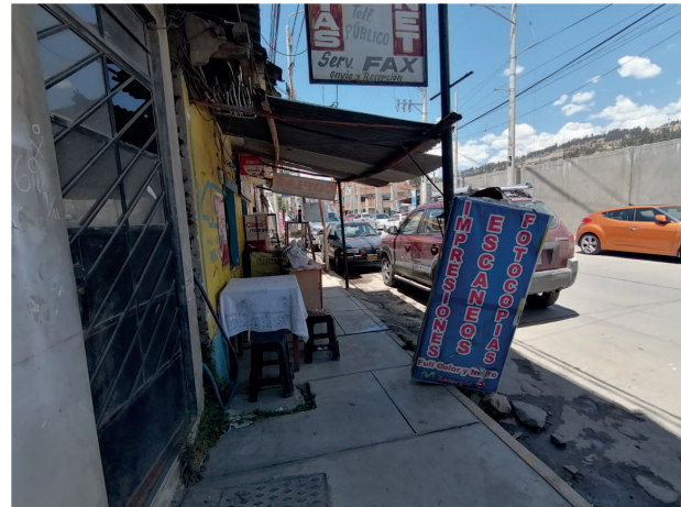
Vereda en la avenida Independencia ocupada por actividades de los vecinos de la zona
