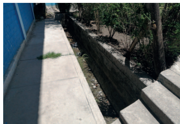
Vereda y escalera de acceso hacia la parte de alcantarillado
