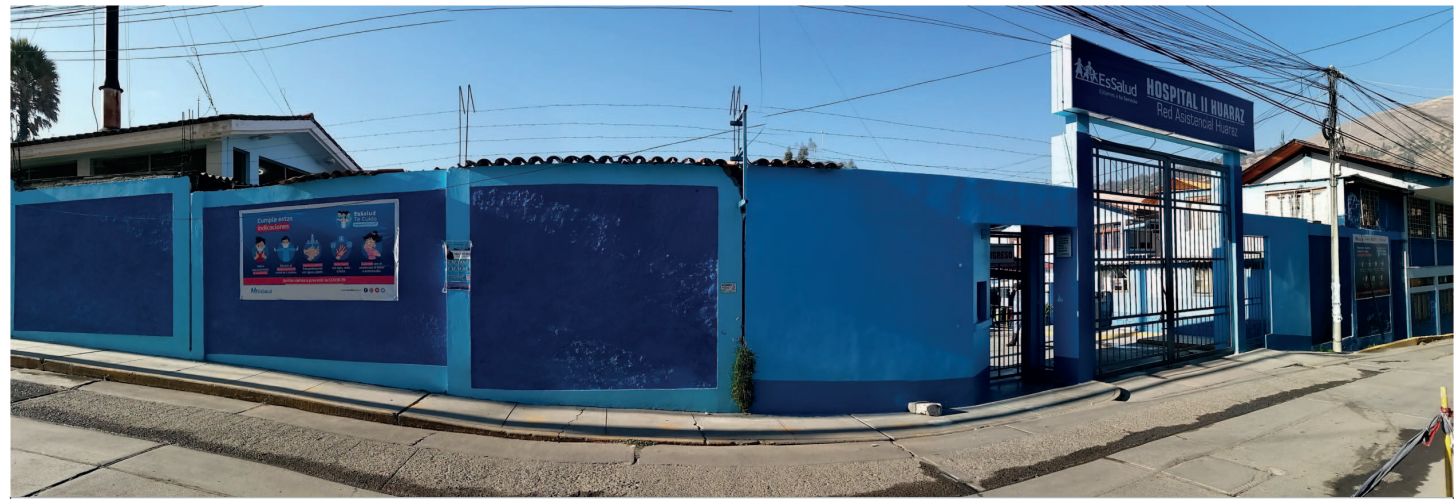
Ingreso principal al Hospital II - Essalud a través del pasaje Sarita Colonia
