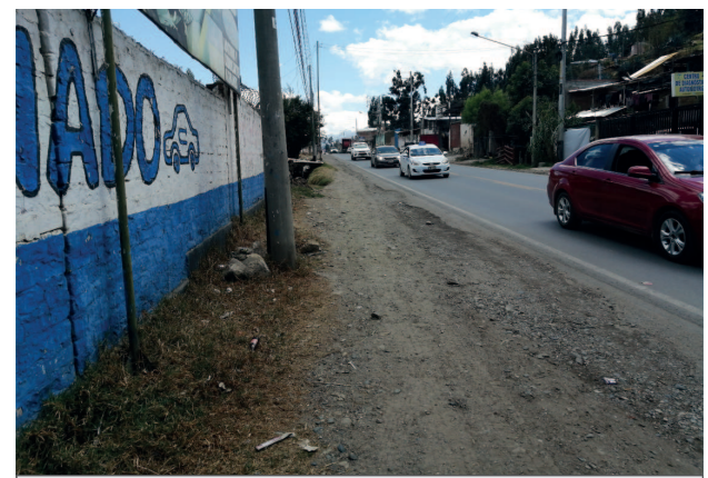
Falta de veredas en la avenida Centenario con solo senderos afirmados para transitar
