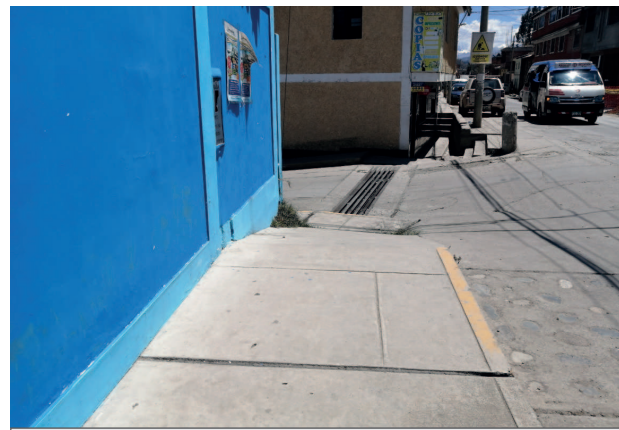
Vereda con pendiente en el cruce entre el pasaje Sarita Colonia y la avenida Independencia
