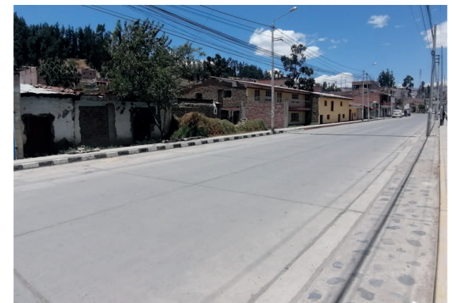
Zona de estacionamiento permitido en las veredas que conectan con viviendas hacia la avenida Independencia
