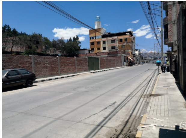
Pista en el tramo entre la primera y segunda puerta del Gobierno regional con tapas selladas de alcantarillado y tierra a los lados
