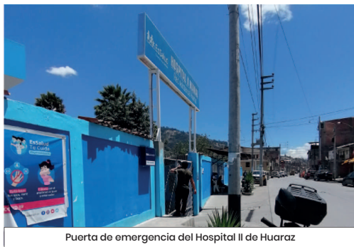
Puerta de emergencia del Hospital II de Huaraz
