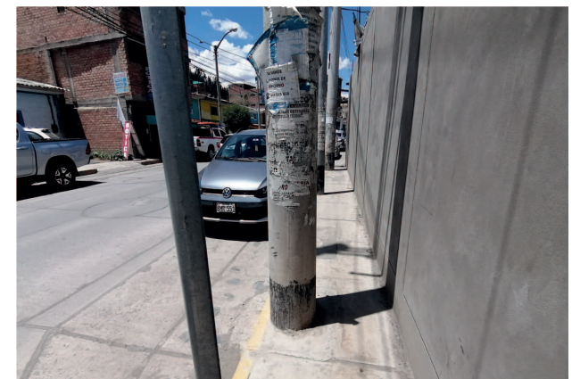
Vereda obstaculizada en la avenida Independencia por el emplazamiento de postes de electricidad
