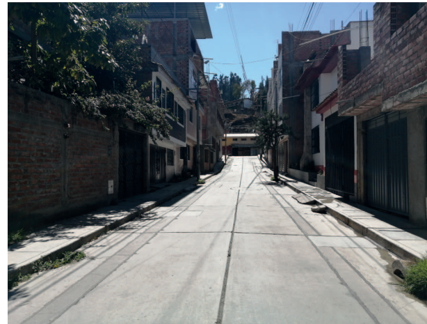
Pista en buen estado con cortes por instalaciones de gas natural y crecimiento de vegetación a los lados
