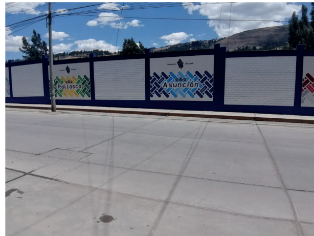
Zona rígida en el tramo de muro perimétrico del Gobierno Regional en la avenida Independencia
