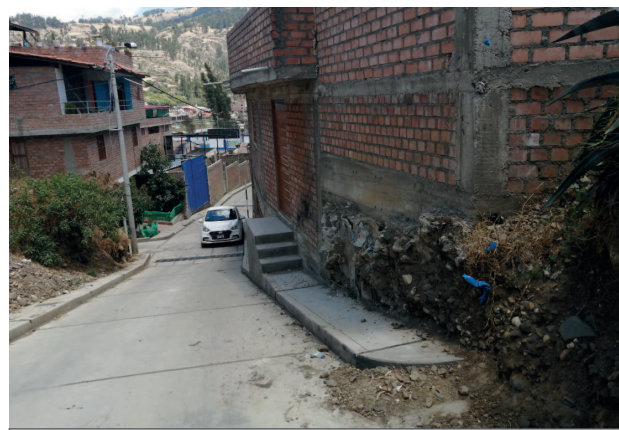
Vereda en el pasaje sin nombre que se encuentra obstruida por escalones de circulación hacia un predio
