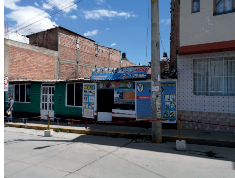
Botica y centro de rehabilitación ubicado al frente del ingreso principal del Hospital
