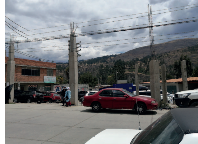
Llegada de vehículos de trabajadores y visitantes al Gobierno Regional
