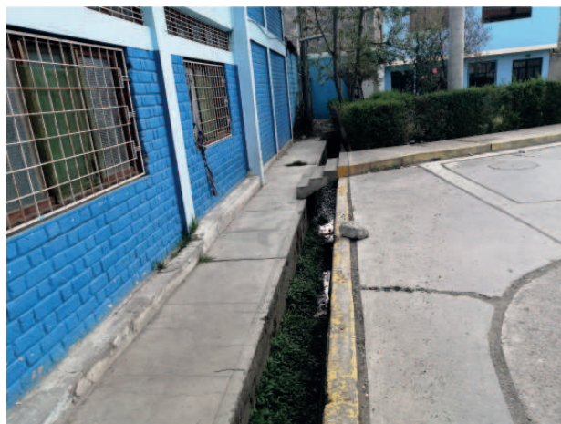
Sector expuesto de alcantarillado fluvial en el pasaje Sarita Colonia en el que tanto pacientes, visitantes y personal de salud vierte desechos
