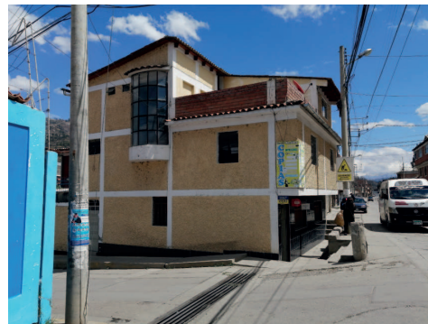
Fotocopiadora ubicada en la esquina del cruce entre el pasaje Sarita Colonia y la avenida Independencia
