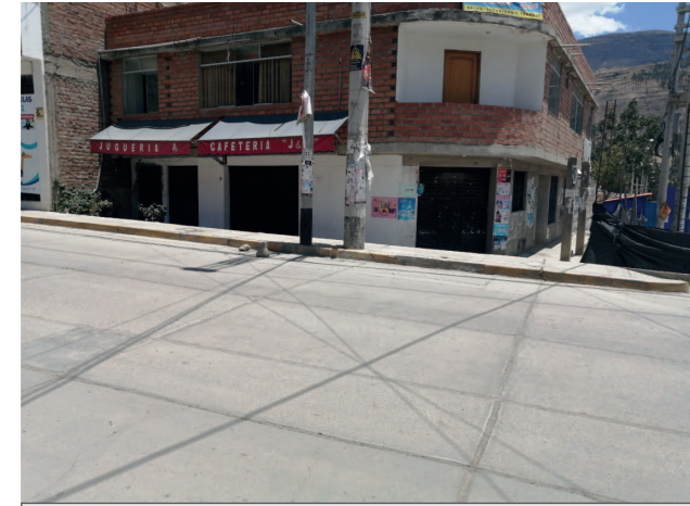
Señalización de zona rígida en las veredas de la avenida Independencia
