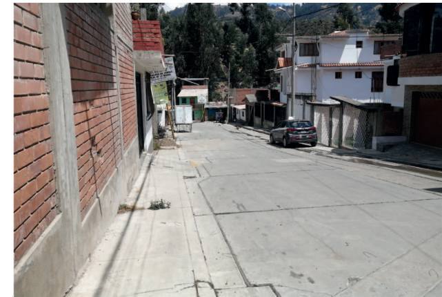
Pista con distintos cortes por las instalaciones de gas natural y rampas vehiculares hacia algunas viviendas
