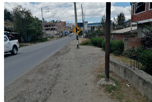
Poste de señalización de "Cruce o pasaje" en el cruce de la avenida Las Casuarinas con la avenida Centenario
