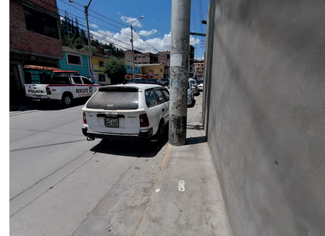
Vereda obstaculizada por el emplazamiento de un poste de electricidad
