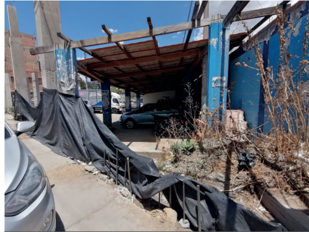
Parte del ingreso hacia la segunda puerta del Gobierno Regional con coberturas deterioradas y columnas expuestas
