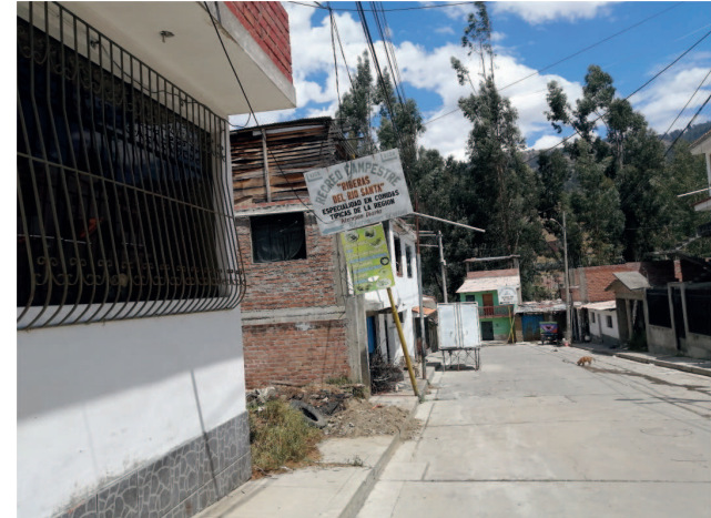
Veredas en el pasaje Sarita Colonia con vegetación crecida y desmonta limitando la circulación
