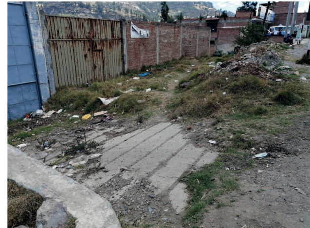
Rampas en mal estado de conservación sin vereda de acceso en la avenida Centenario
