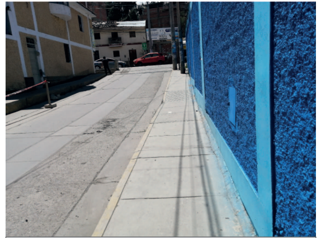
Veredas en pendiente en el pasaje Sarita Colonia que llevan al ingreso principal del hospital
