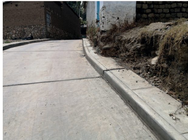
Veredas estrechas en uno de los pasajes sin nombre que conecta la avenida Independencia con la avenida Centenario
