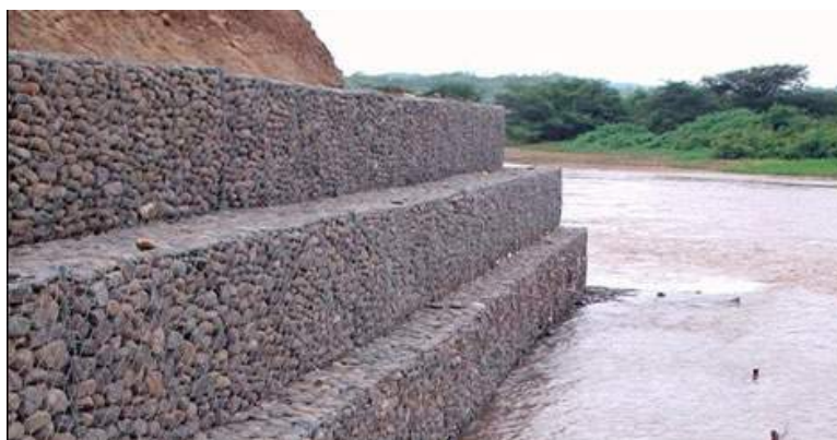
Figura N° 3 Defensa ribereña estructural: Gaviones
