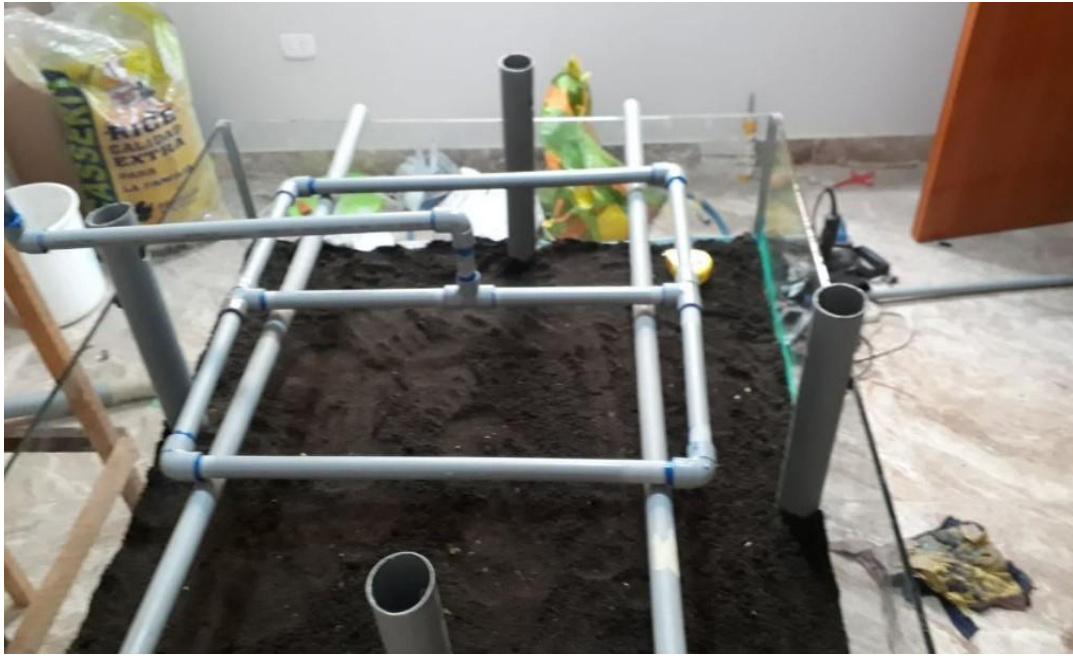
IMAGEN N° 05. Instalación de tuberías para biofiltro.
