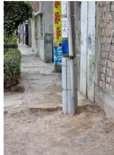
Nota: dentro del área de estudio se observó diversas barreras en la vía pública tales como, veredas en mal estado, agrietada y en desnivel de pasos, así como rampas muy pronunciadas y deterioradas y en otros casos la carencia de estos dos elementos.
