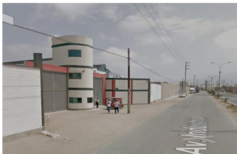
Figura 2. Vista lateral en la Av. Industrial
