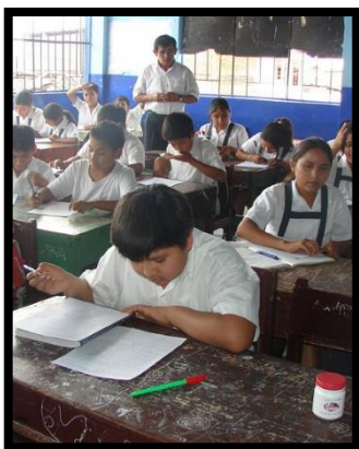
Figura 01 – Estado actual de aulas de clases nivel secundaria.
