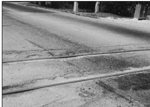
Figura 17. Cruce de Vía Férrea
