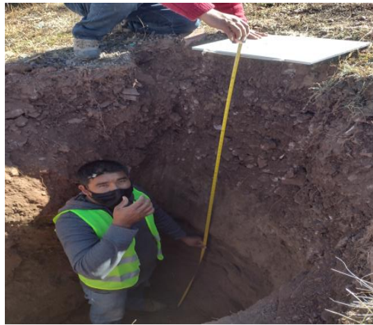
foto 08: Se observa en la imagen la altura de la calicata, y la altura del estrato conformado.
