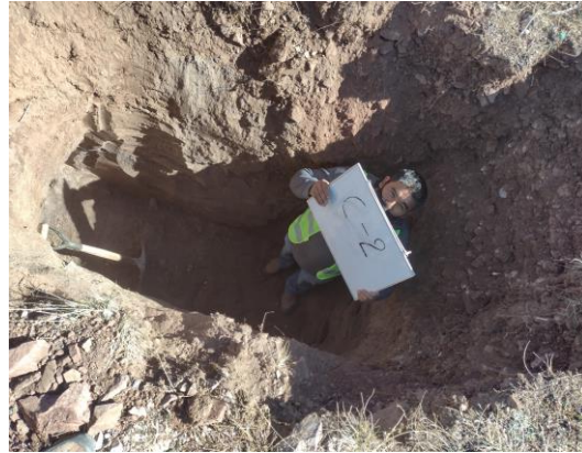
foto 02: En el 05+500, se aprecia en la topografía la calicata 2.
