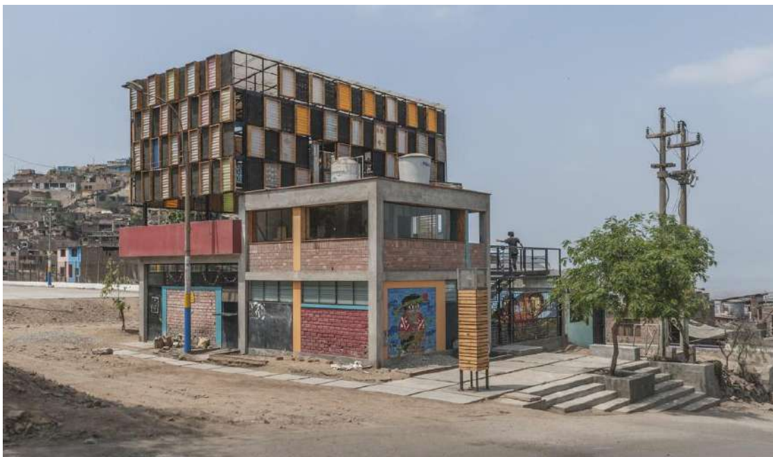
Figura 15/Proyecto Fitekantropus culminado
