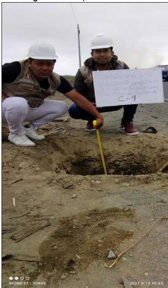
Figura 1: Punto para calicata C-01
