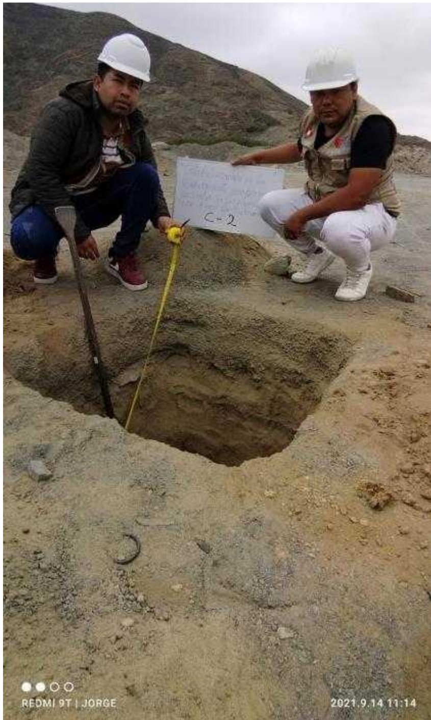
Figura 2: Punto para calicata C-02
