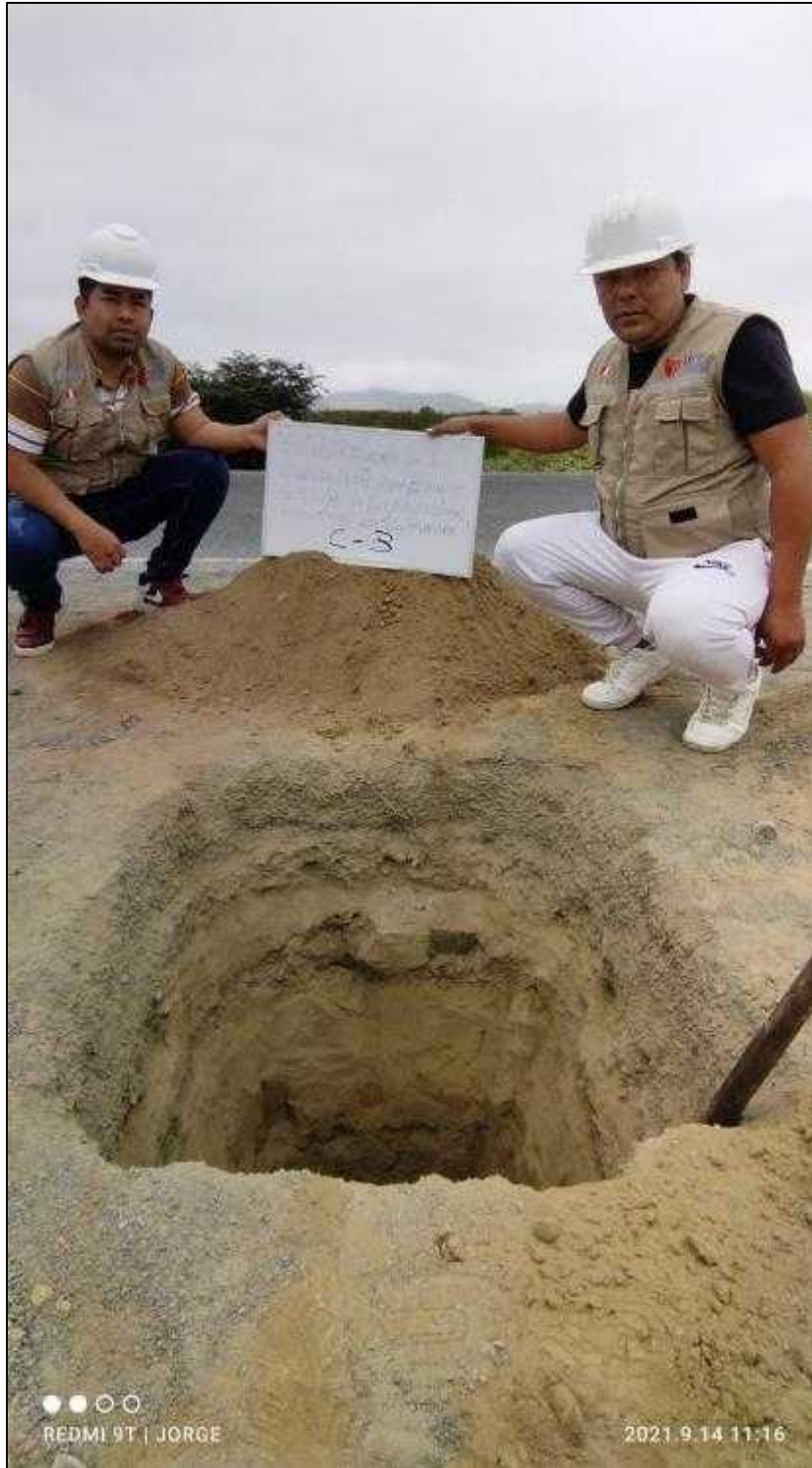
Figura 3: Punto para calicata C-03
