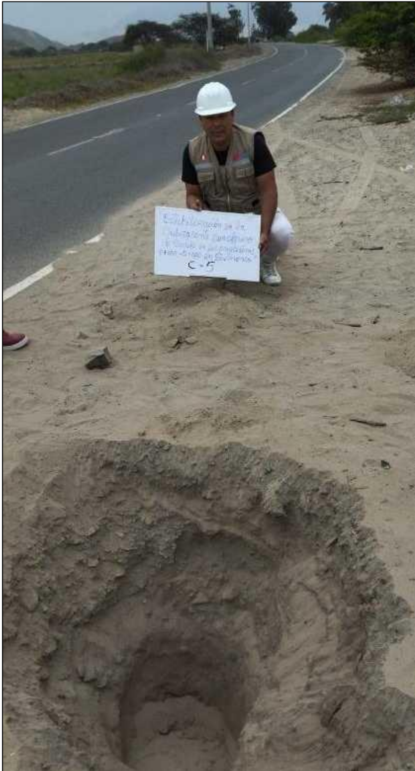
Figura 5: Punto para calicata C-05
