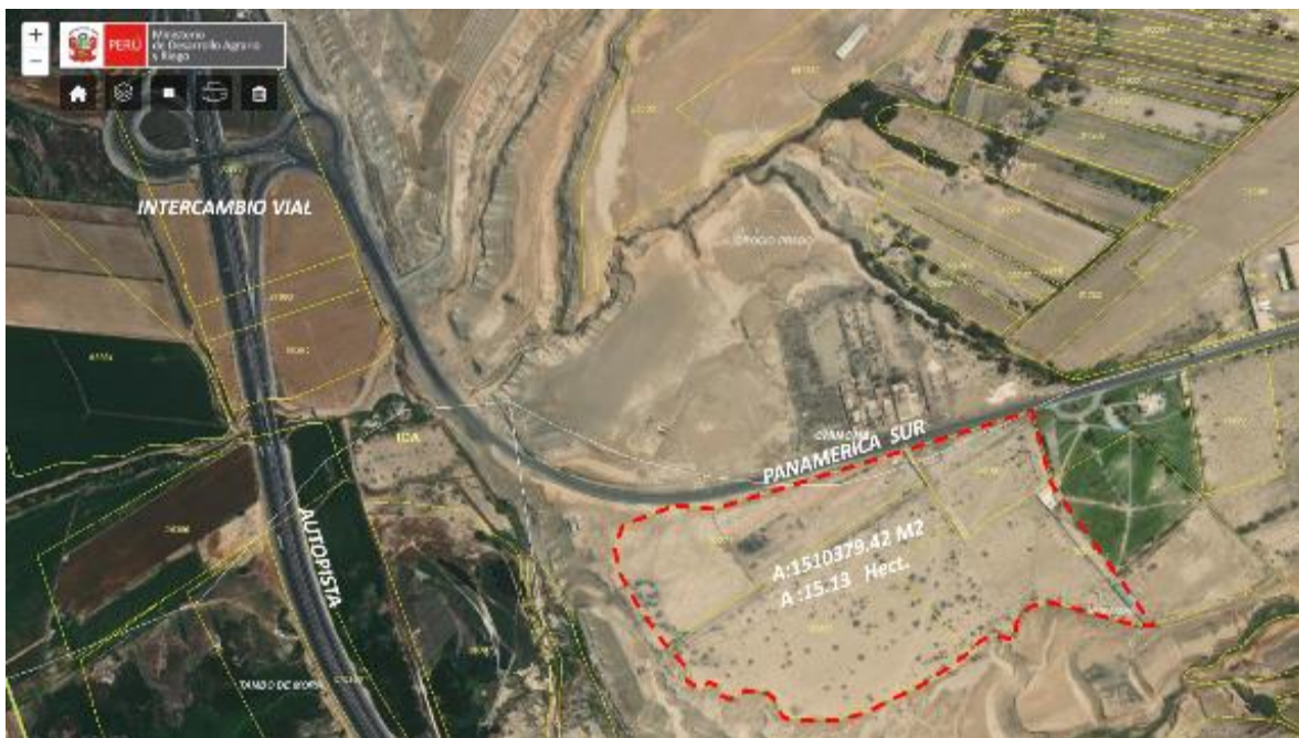
Ilustración 49 Ubicación del terreno, al ingreso de la provincia de Chinch
