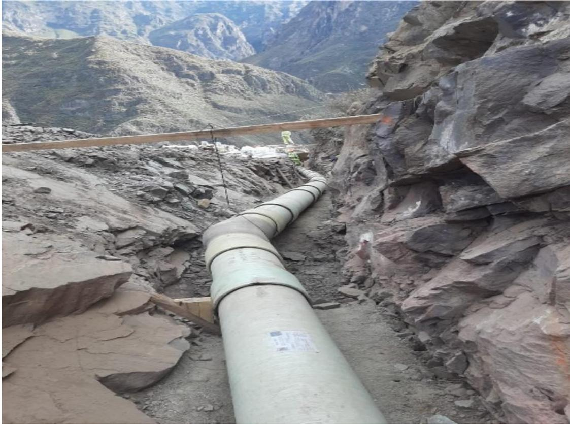
Foto 9. Instalación de nueva tubería
