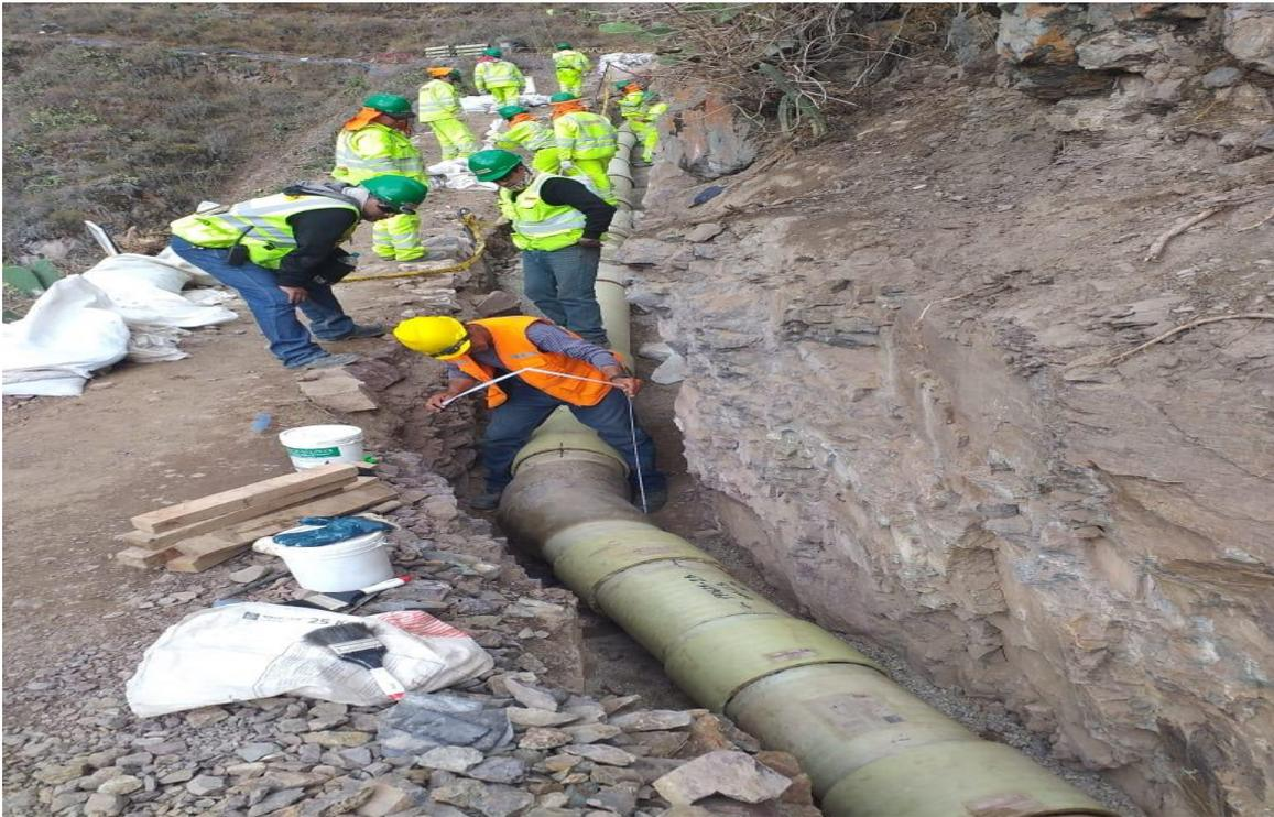
Foto 1. Medición de profundidad de zanja de tubería instalada.
