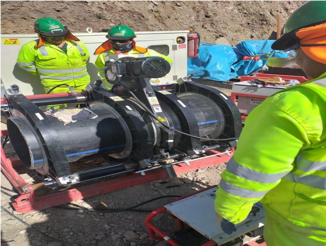
Foto 4. Termofusión de tubería HDPE de 450mm
