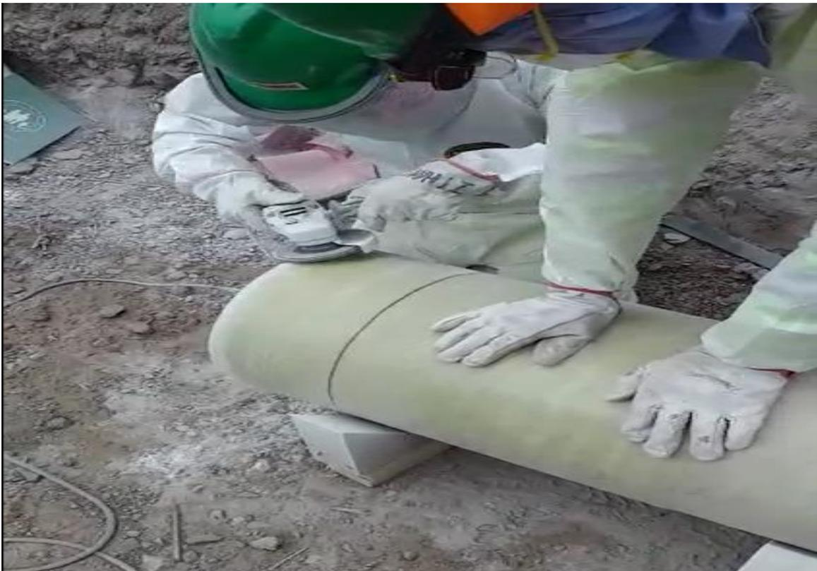
Foto 2. Esmerilado de tubería para embone y traslape
