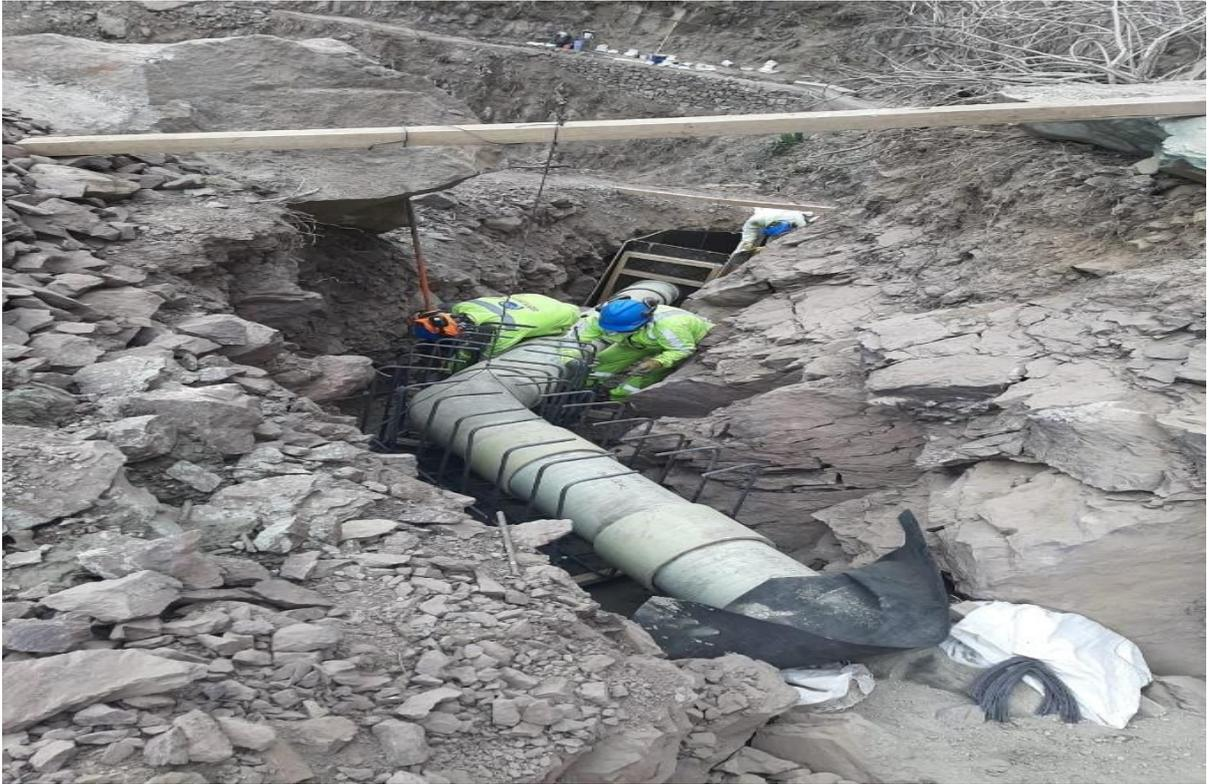
Foto5. Construcción de nuevo tramo de tubería
