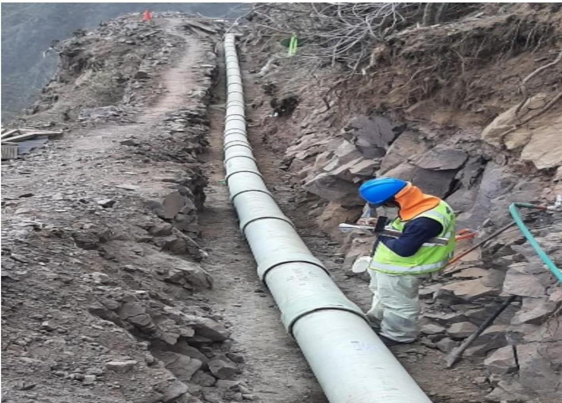
Foto 10. Inspección de instalación de tubería
