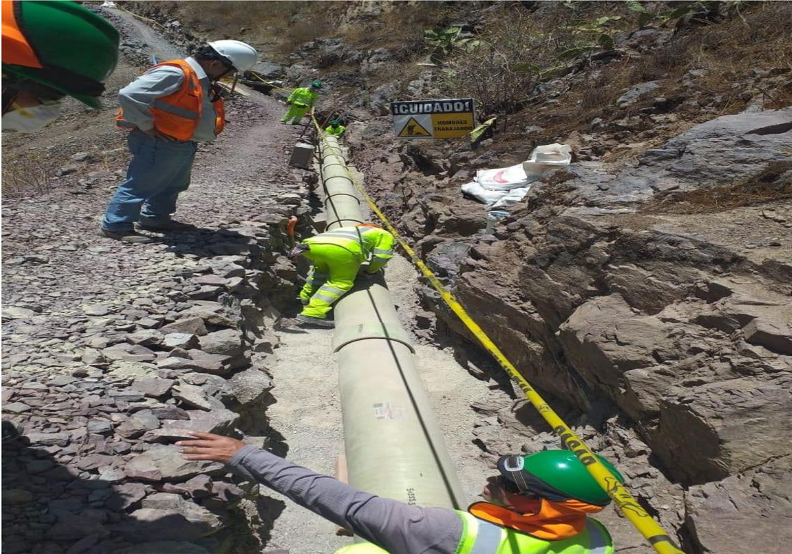
Foto 3. Inspección de relleno de tubería
