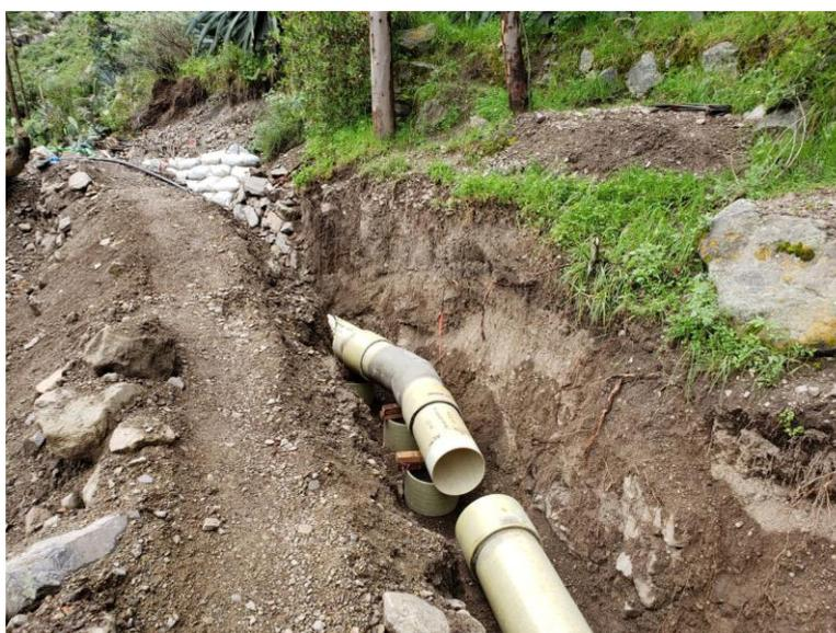
Figura 1. Instalación de tubería PRFV
