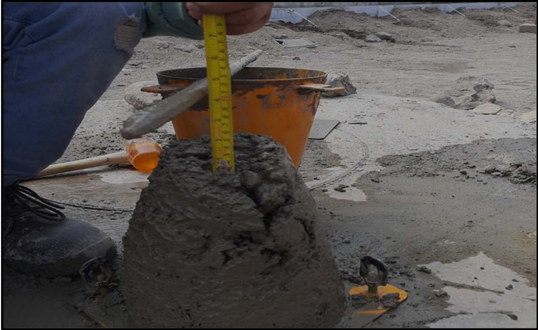
Figura 3. Medición del slump en concreto con aditivo (1 lts) Fuente: elaboración propia.
