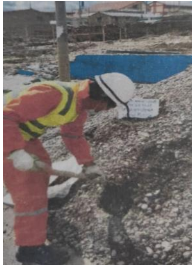
Figura 4. extracción de muestra del volumen de agregado en obra.
