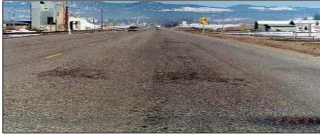
*Figura 20.* Desprendimiento de agregados
