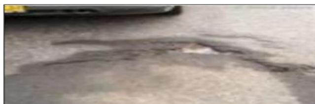
*Figura 19. Grieta Parabólica*
