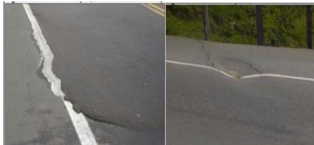
*Figura 4. Abultamientos y Hundimientos*
