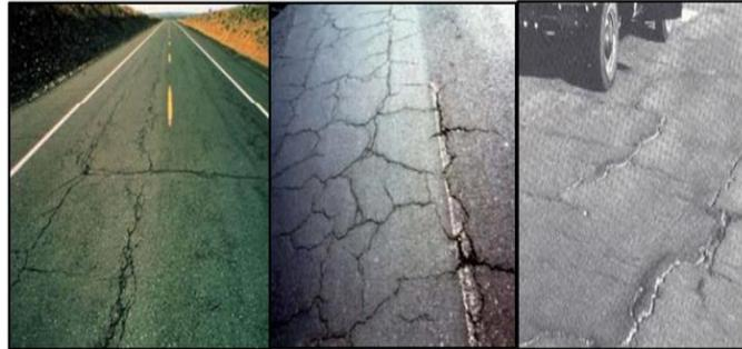
*Figura 3. Agrietamiento en bloque*
