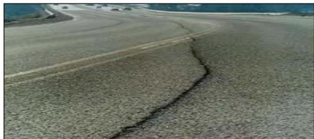
*Figura 15.* Grietas Longitudinales y transversales
