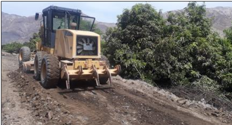
Escarificado de base granular con motonivalodora km 7+000
