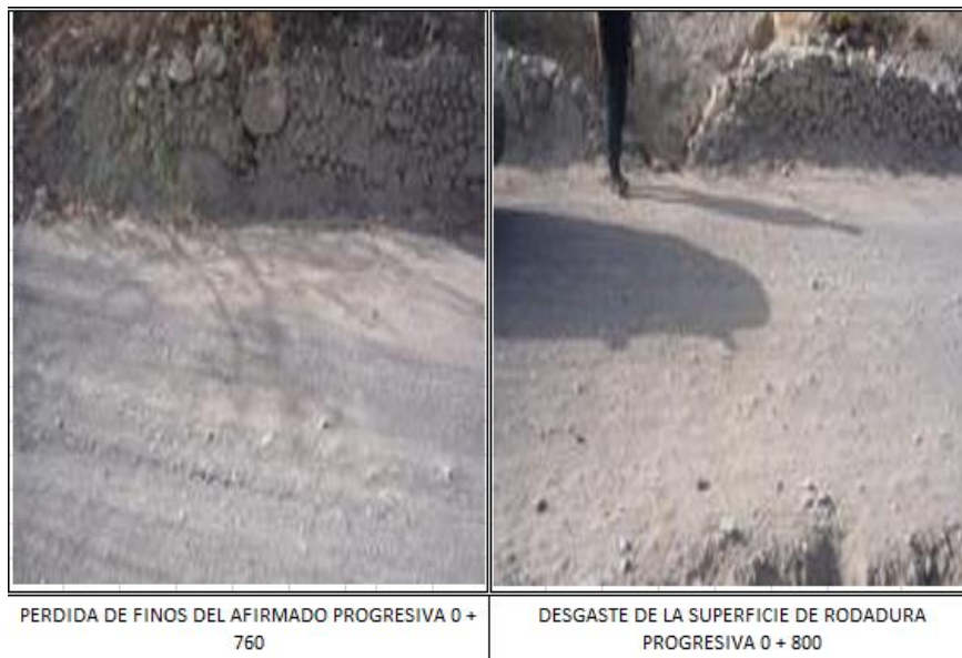
Figura 4. Superficie de rodadura desgastada y encalaminado
