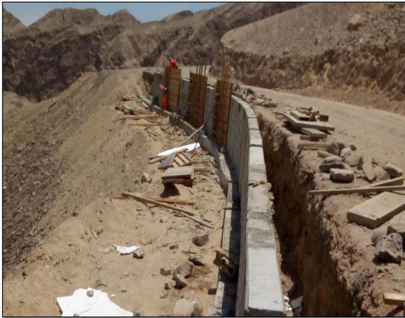
Desencofrado de muro de contención L=13.50m prog km 9+560
