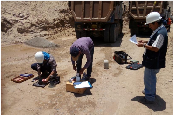
Realización de ensayo de compactación base granula prog km 6+000
