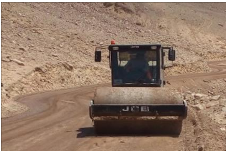
Compactación de base granular con rodillo prog km 13+000km
