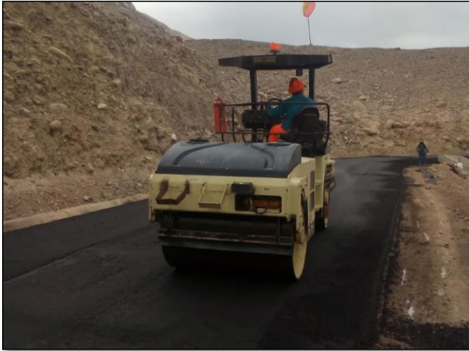
Compactación de carpeta asfáltica con rodillo neumático prog km 10+000
