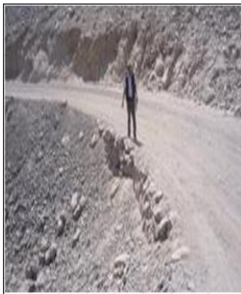
MURO DE CONTENCION EXISTENTE PROGRESIVA 7 + 110.
