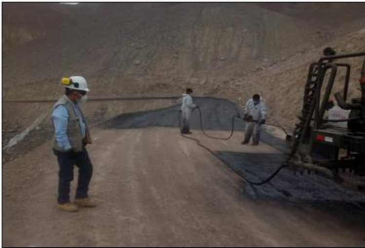
El supervisor de obra en la Imprimación asfáltica en el tramo km 11+000
