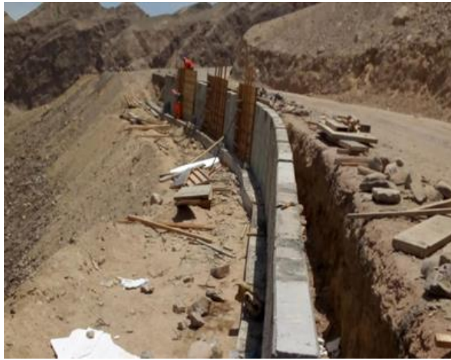
Figura 15. Construcción de muro de contención
