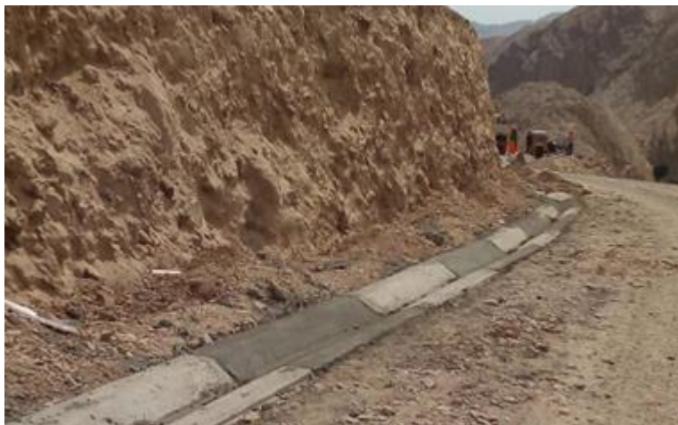
Figura 16. Sistema de drenaje - cunetas
