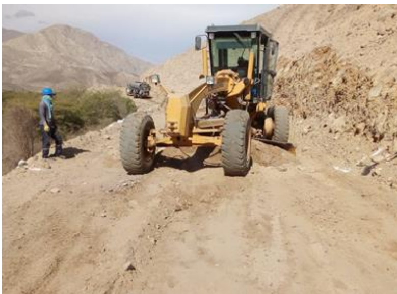
Figura 12. Nivelación de plataforma
