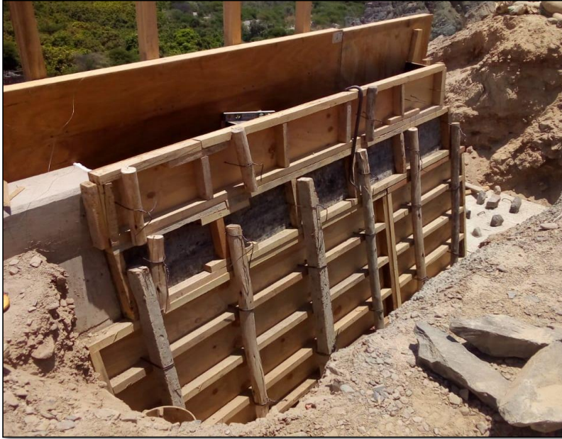
Encofrado de muro contención L=2.50m prog. km8+450
