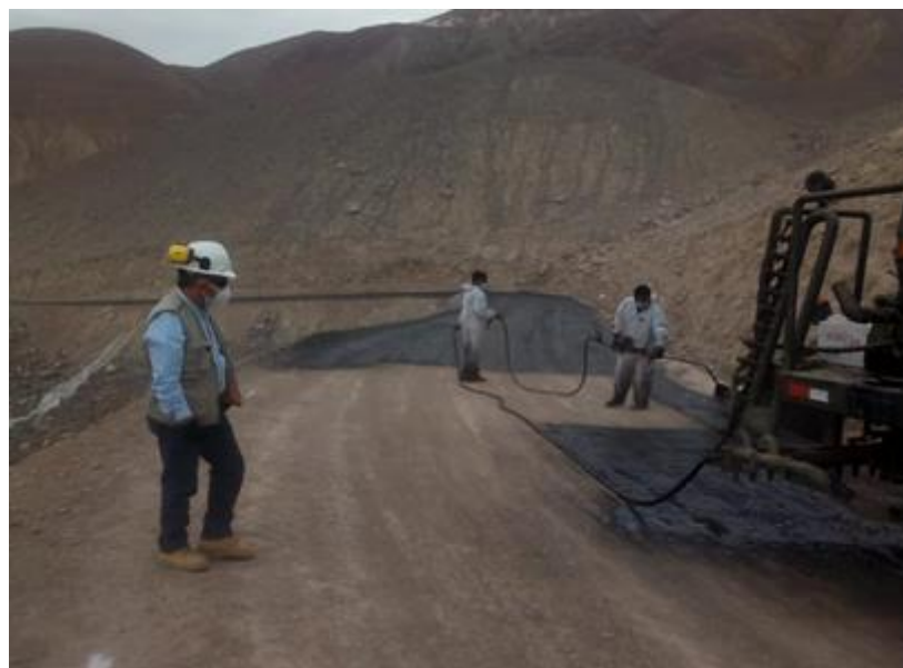
Figura 13. Imprimación asfáltica en plataforma
