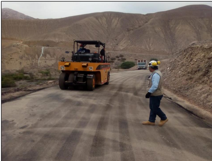
Trabajos de corte de material suelto en la prog. km 10+000
