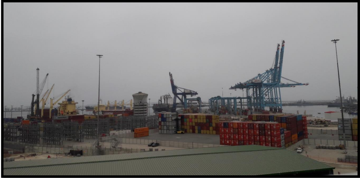
Figura 1. Vista de las grúas Post Panamax del Terminal Multipropósito Operario por APM Terminal Callao.
