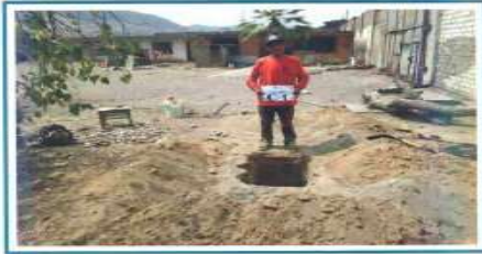
FOTO N° 3: Vista panorámica donde se aprecia la ubicación del pozo C-1.
