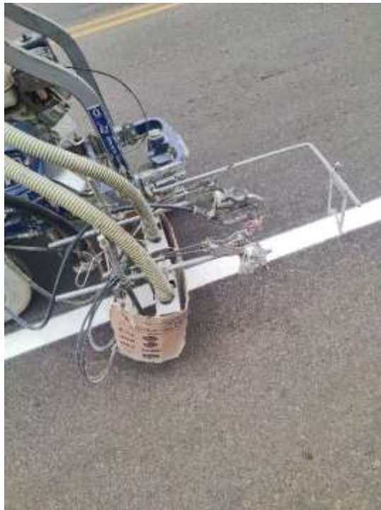
Figura 21. Maquina delineadora pintado
