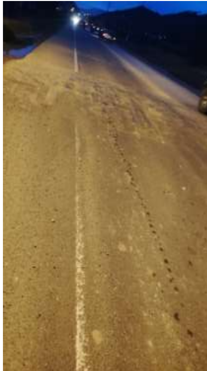
Figura 27. Eje después de tres meses de pintado en la vía Cusco – Lucre
