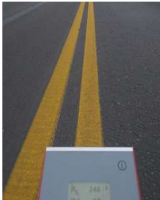
Figura 23. Medición de retroreflectividad del eje central
