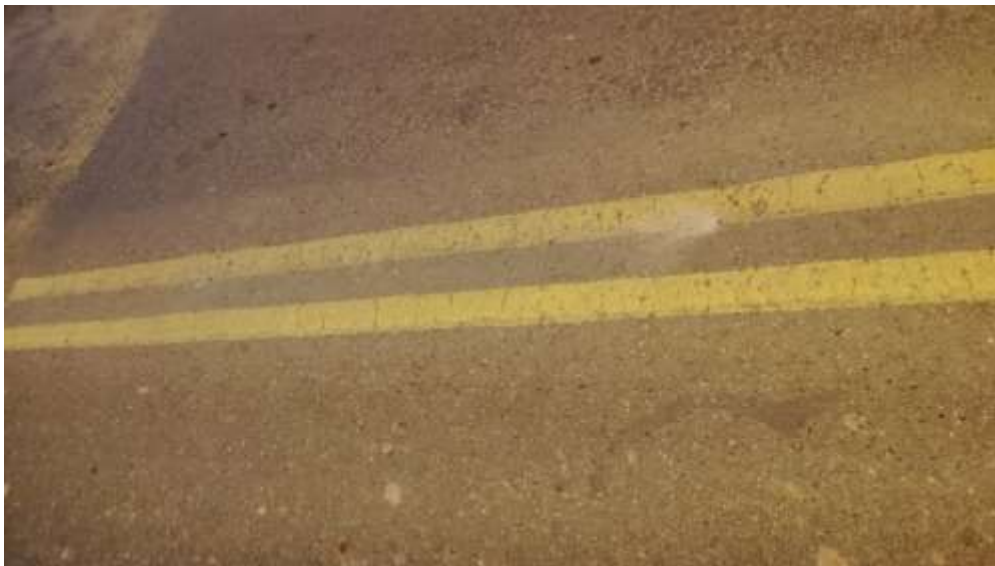
Figura 28. Eje central después de un mes y medio de pintado en la vía Cusco - Lucre
