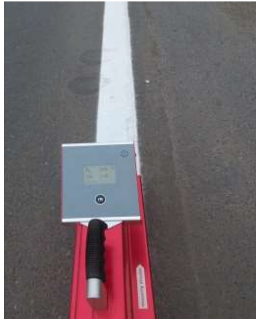
Figura 20. Midiendo la retroreflectividad de las líneas horizontales vía Cusco - Lucre
