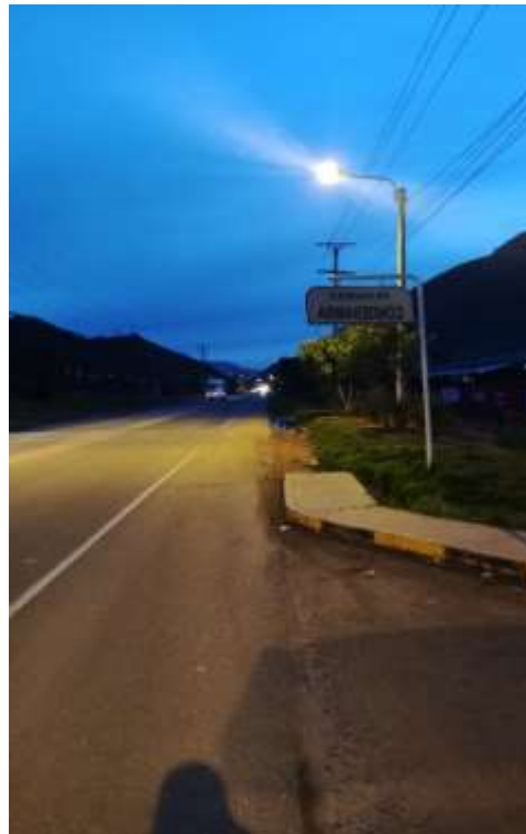
Figura 31. Eje derecho después de instantes de pintado den la vía Lucre – Cusco
