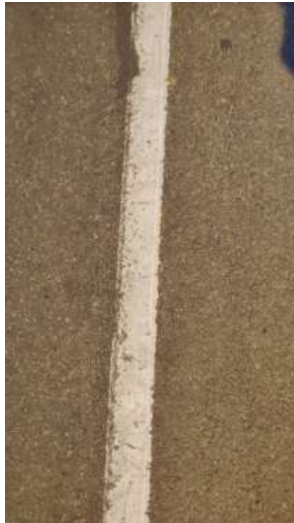
Figura 24. Eje después de un mes de pintado en la vía Cusco – Lucre
