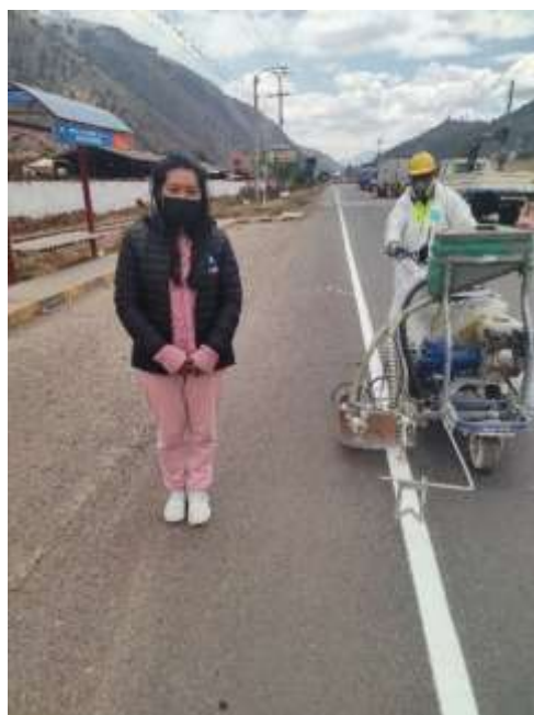
Figura 19. Evidencia del control de pintado vía Cusco - Lucre
