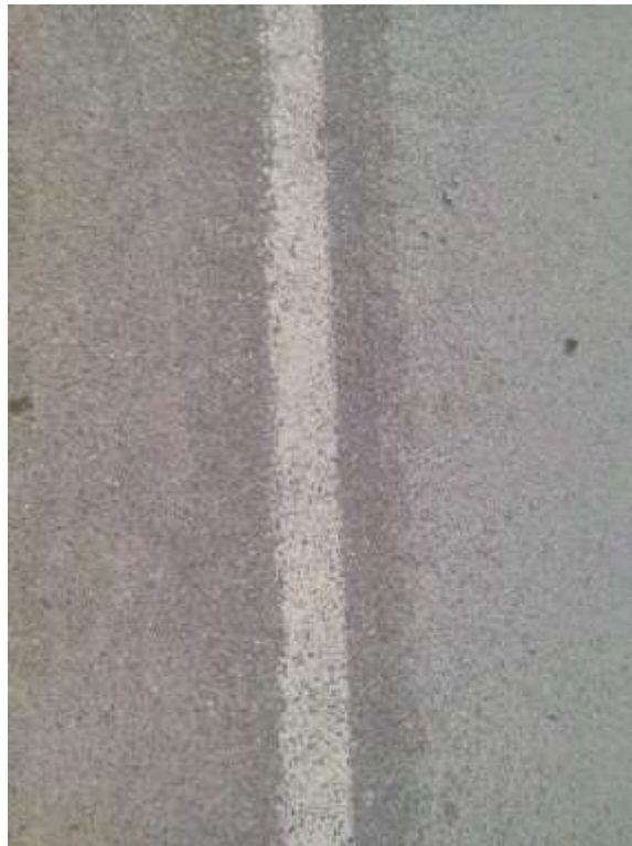
Figura 32. Eje Izquierdo después de dos meses y medio de pintado en la vía Cusco - Lucre
