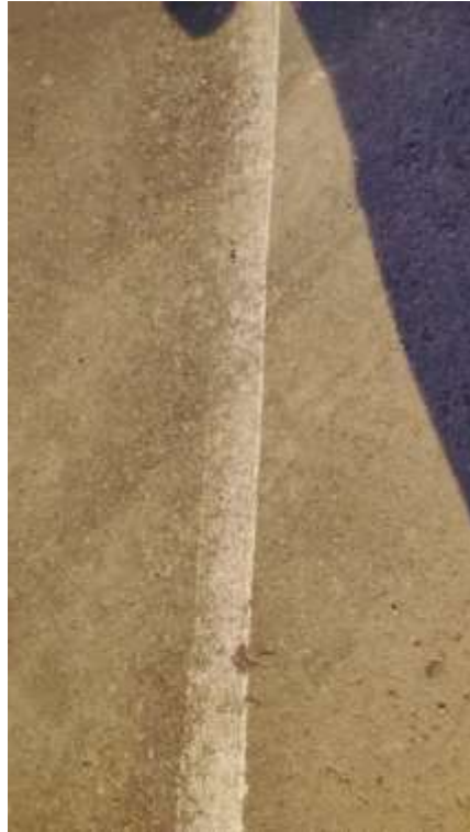
Figura 26. Eje derecho después de tres meses de pintado en la vía Cusco – Lucre
