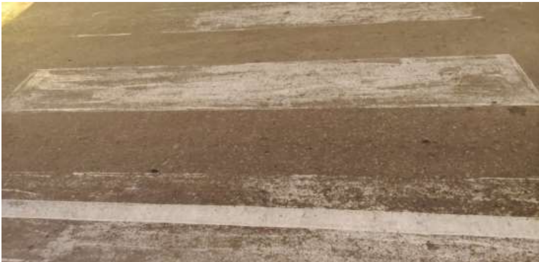
Figura 25. Líneas peatonales después de dos meses y medio de pintado en la vía Cusco – Lucre
