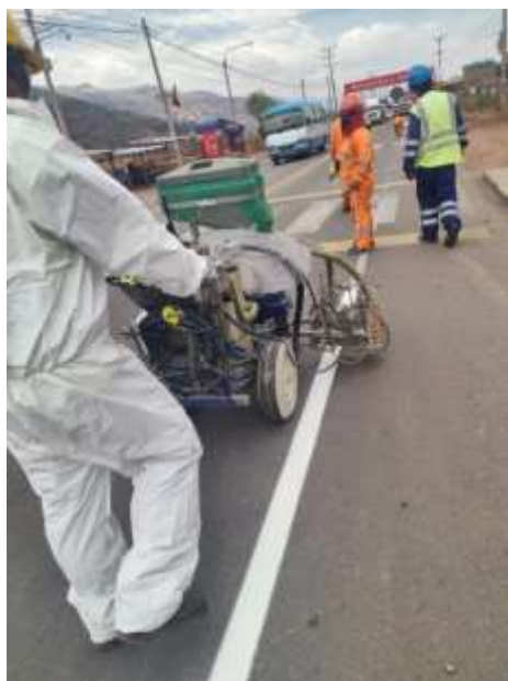
Figura 18. Pintado de eje derecho de la vía cusco – lucre
