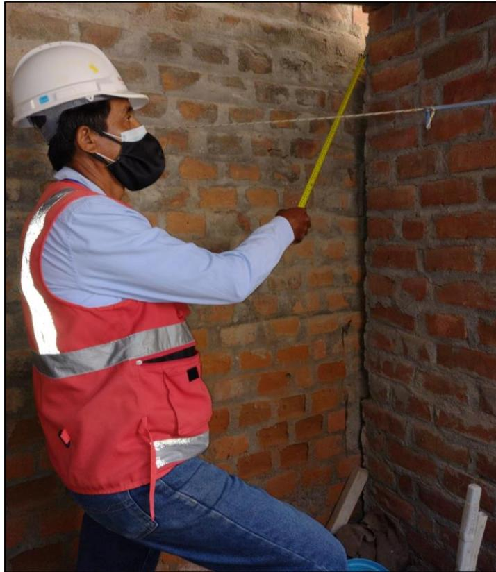
**Figura 20** Barrio Buenos Aires, Calle 7 # 812, Malas conexiones entre muros
