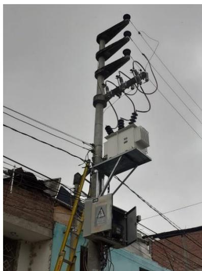
*Nota:* La figura representa un poste de concreto armado que sostiene a las tres fases del alimentador mediante sus ménsulas, además 3 seccionadores tipo cut out que sirven de conexión hacia los bushings del transformador. Fotografía brindada por *L&H Contratistas - Jaén*.
