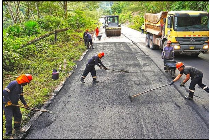
Figura 2. Construcción de carreteras
