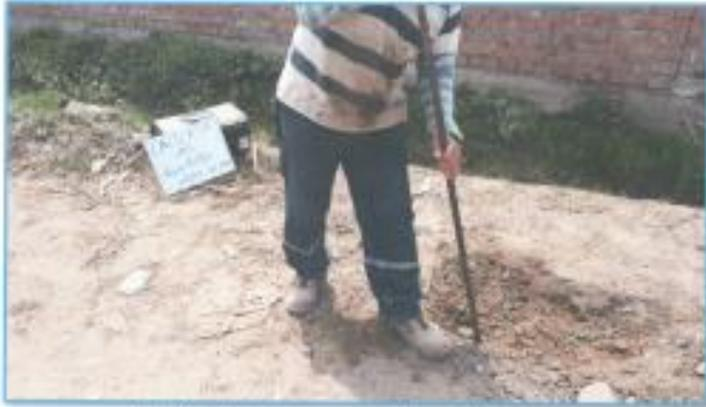
FOTO N°81 – Inicio de la excavación manual para la Calicata C-01.
