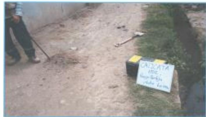
FOTO N°84 – Inicio de la excavación manual para la Calicata C-02.
