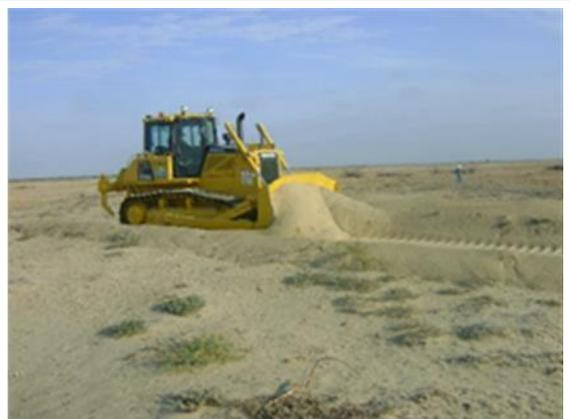
Foto N°12.- Nivelación con Tractor de Oruga.
