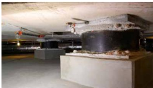
Figura 3. Aislador sísmico de goma.
