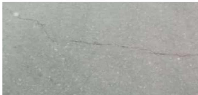
Figura 25. Fisura delgada
