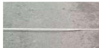
Figura 13. Depresión 3b entre 2 cm y 4 cm
