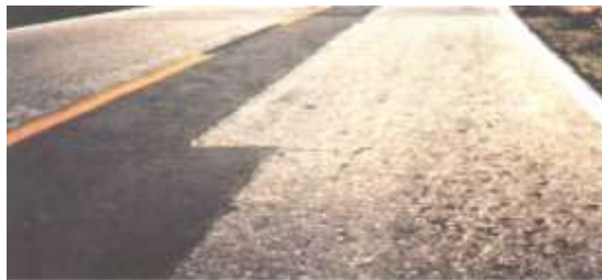
Figura 17. Reparación en fallas superficiales
