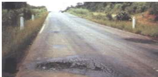
Figura 19. Reparación de fisuras en mala condición
