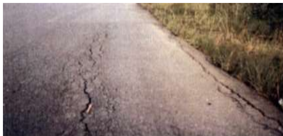
Figura 9. Fisura ancha
