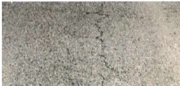
Figura 8. Fisura media
