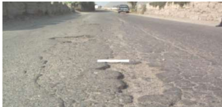
Figura 24. Huecos con diámetro entre 20 y 50 cm
