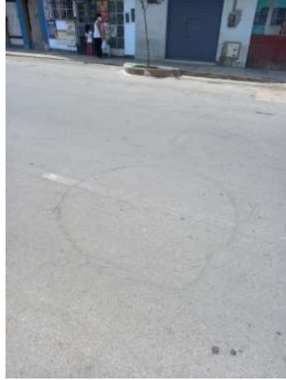
Fotografía 08: Grieta parabólica
