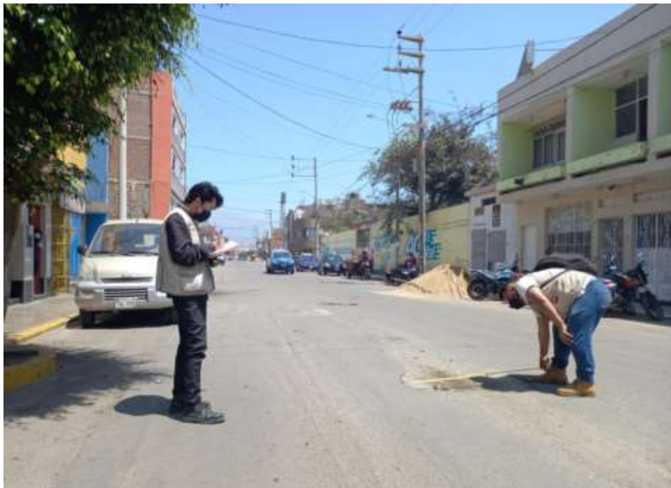
Fotografía 02: Inspección visual de las fallas del pavimento
