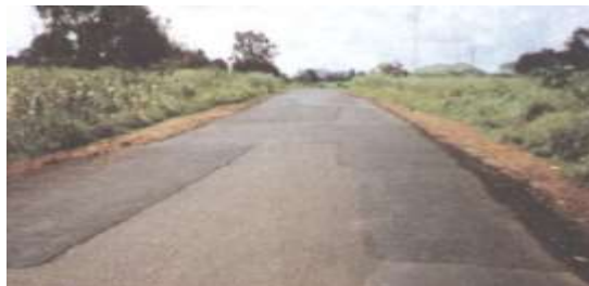
Figura 18. Reparación de fisuras en buena condición
