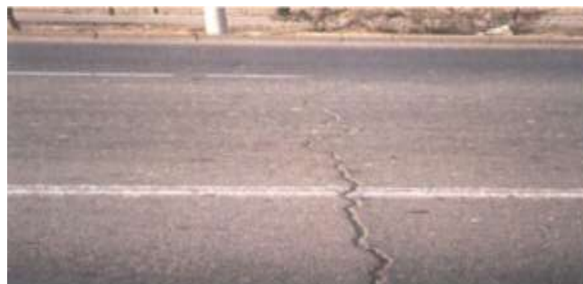
Figura 26. Fisura ancha
