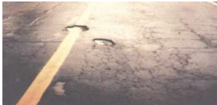
Figura 23. Huecos con diámetro menor a 20 cm
