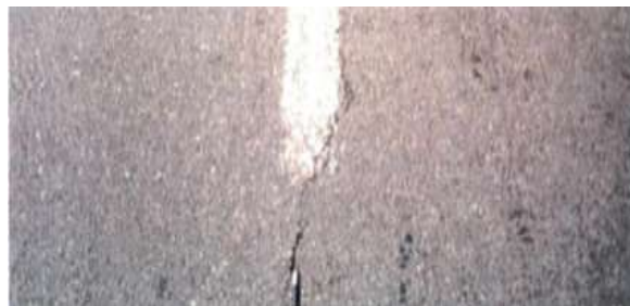
Figura 7. Fisura delgada
