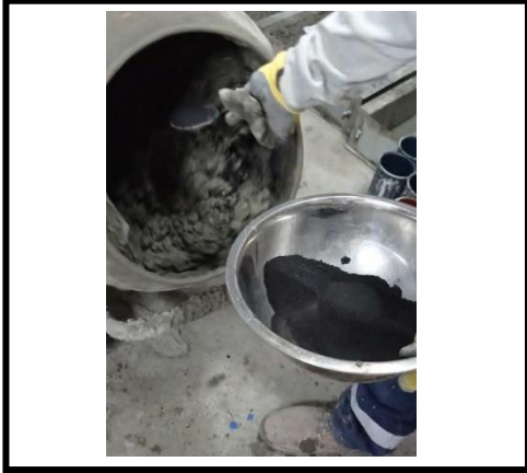
Figura 43. Adición de ceniza de Tara 2% a la mezcla de concreto.
