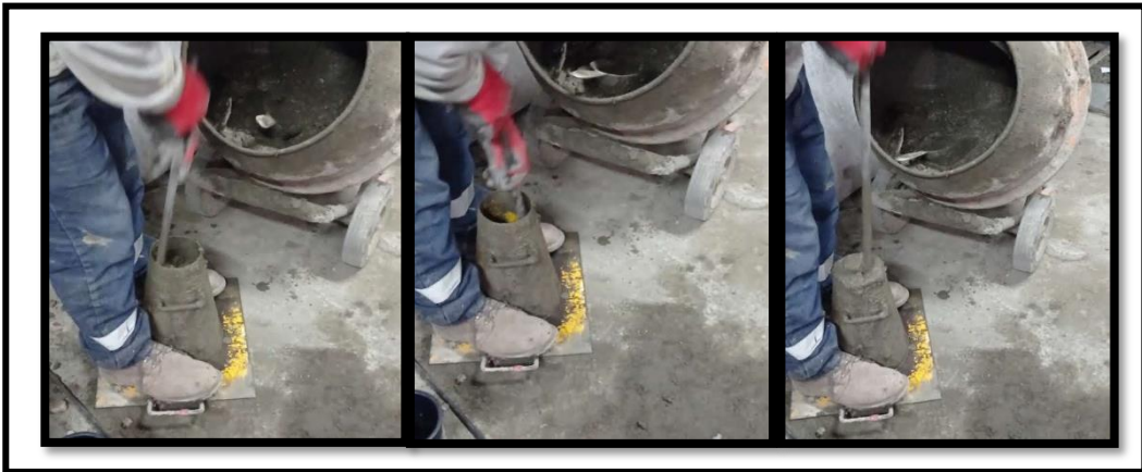
Figura 45. Llenado de mezcla en 3 capas, chuceo con varilla 25 golpes por c/capa y llenado de testigos.
