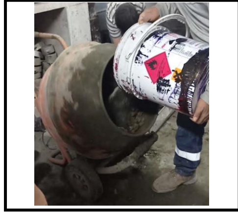
Figura 8. Mezcla de materiales para realizar las pruebas SLUMP con las dosificaciones
