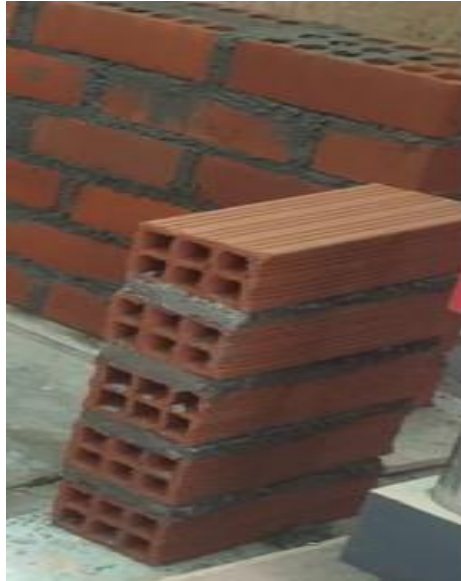
Figura 24. Construcción de pilas Fuente: propia
