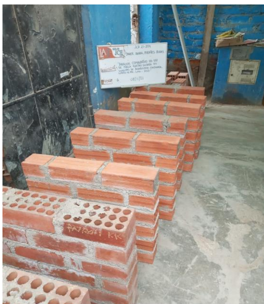
Figura 25. Construcción de muretes Imagen: propia
