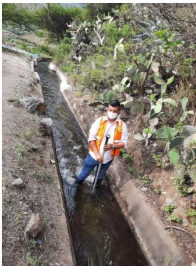
FOTOGRAFIA N° 6: Punto Aforo 10 – Canal Sahuinto.
