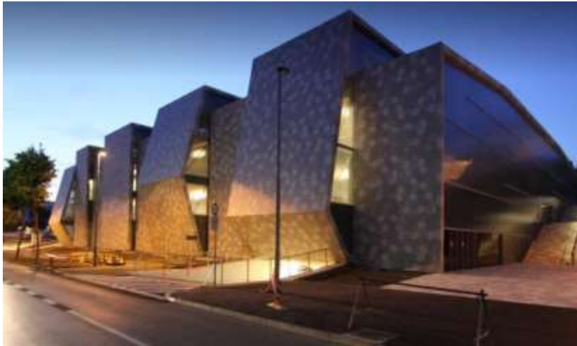
Figura 6 Vista de la Fachada Sur Zamet Centre
