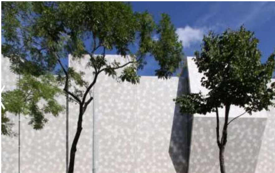
Vista exterior Fachada Zamet Centre
