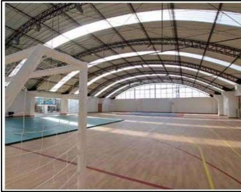
Figura Figura 36 Vista interior del Polideportivo
