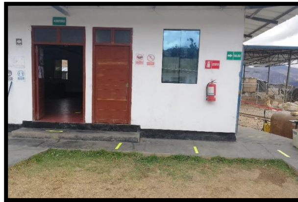
Foto 5: señalización respectiva para el distanciamiento obligatorio.
