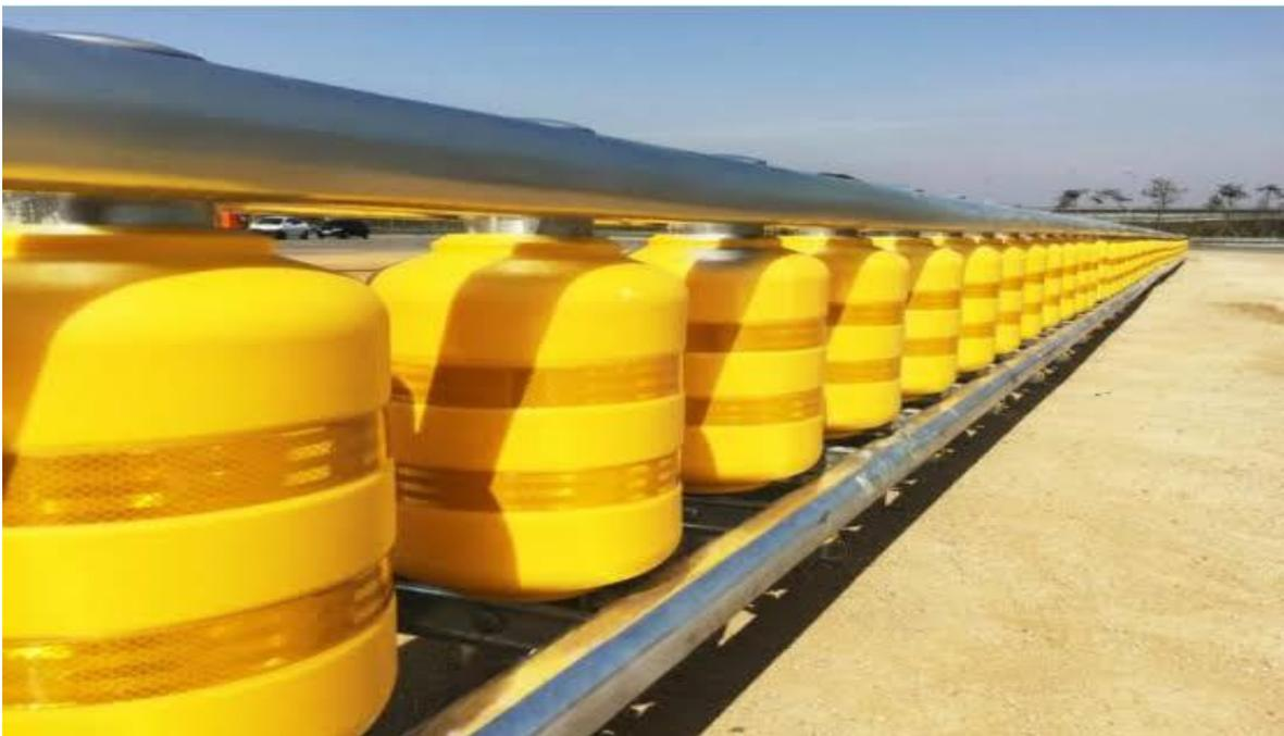
***Ilustración 69*** Los cilindros giratorios B
