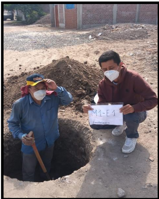
Fotografía N° 3. Obtención de muestra a través de calicata (Lambayeque).
