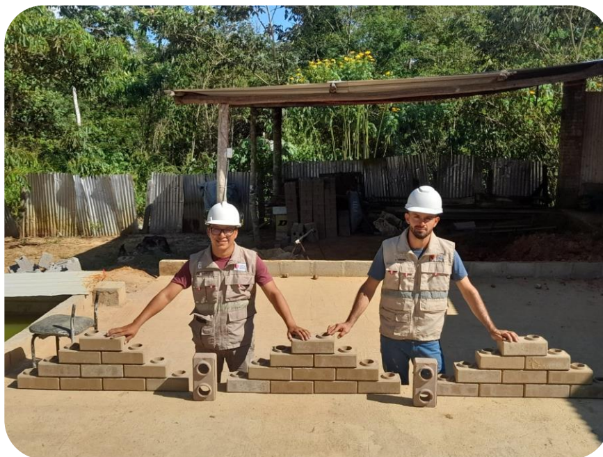
Vista fotográfica N°20: Se observa ya concluido el levantamiento de los 3 tipos de ladrillos ecológicos
