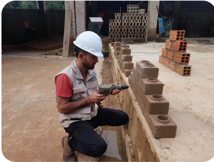
Vista fotográfica N°22: Se observa ya las perforaciones en los 3 ladrillos ecológicos y en el ladrillo comercial.
