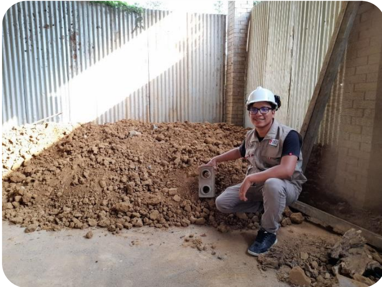
Vista fotográfica N°03: Se observa el material de la arcilla en bruto con la cual se trabajó para el ladrillo.
