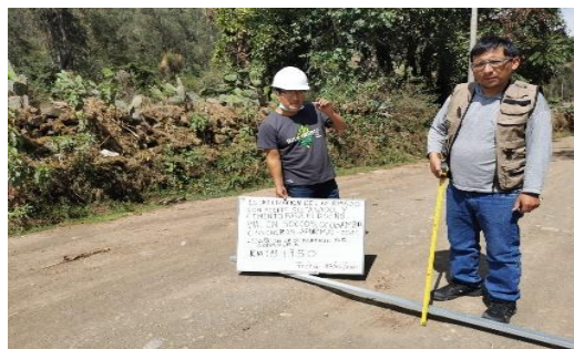
Figura 6: Evaluación de daños (km 13+750)
