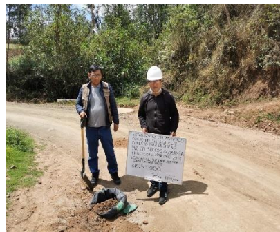
Figura 9: Extracción de material de km (5+000)
