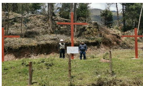
Figura 1: Evaluación de daños (Tres cruces)
