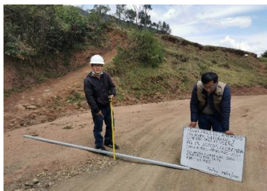
Figura 3: Evaluación de daños (km 6+750)
