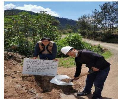
Figura 10: Extracción de material de km (10+000)
