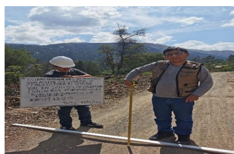
Figura 8: Evaluación de daños (km 17+500)
