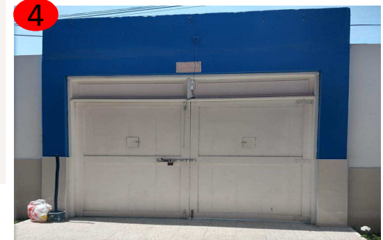
4 Ambos portones del edificio son de doble puerta de material metálico. Se emplearon puertas contra placadas para las puertas de las aulas.
