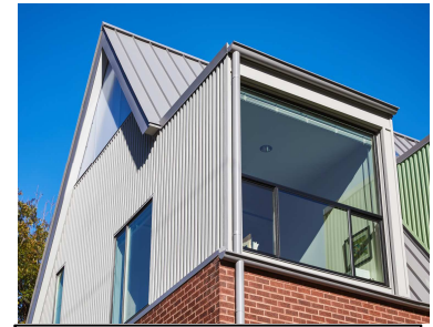
VENTILACION E ILUMINACION
