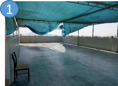
FUENTE: PROPIA PATIO CUARTO PISO – JAQUES DELORS
