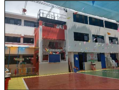
FUENTE: Propia Elevación principal del pabellón adaptado
