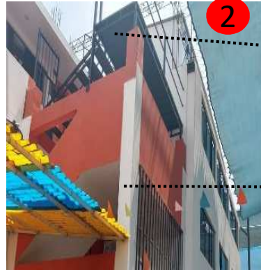
FUENTE: MARÍA MERCEDES ESCALERAS - CIRCULACIÓN VERTICAL
