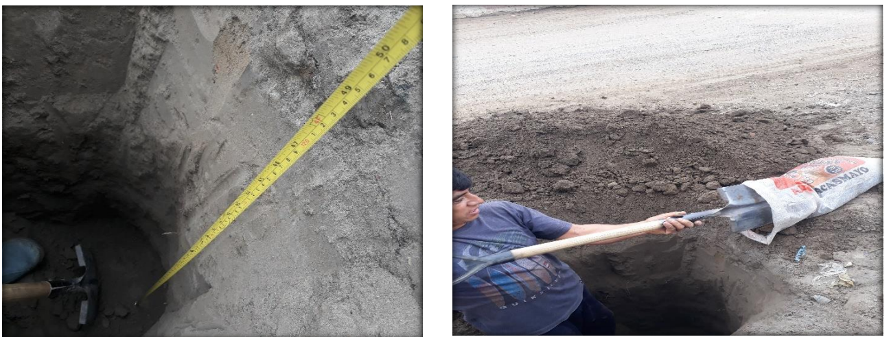
FIGURA N°14 - profundidad excavada de la Calicata C-2.
