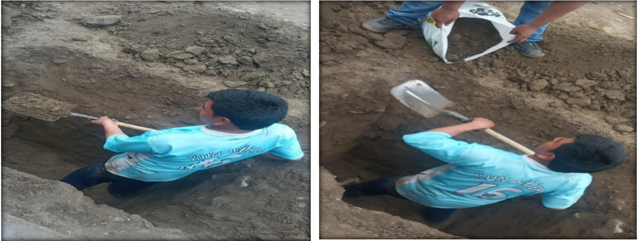
FIGURA N°13 - Profundidad excavada de la Calicata C-1.
