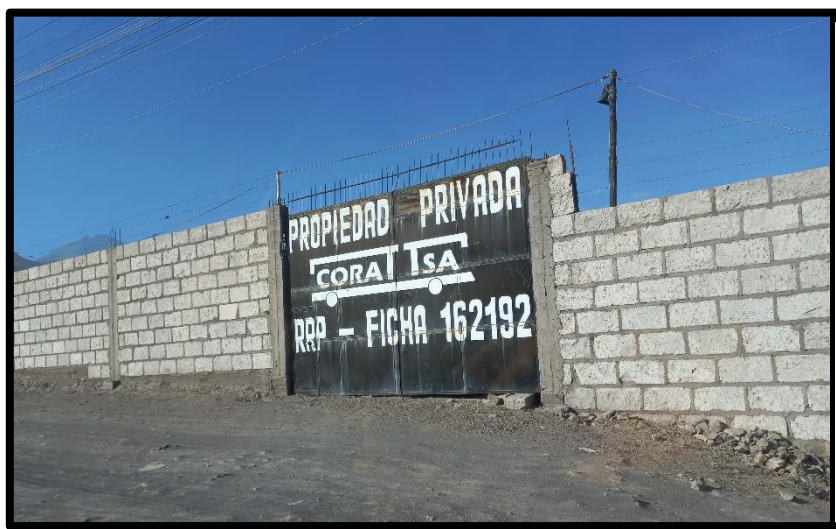
Figura 101: Vista de Fachada de
