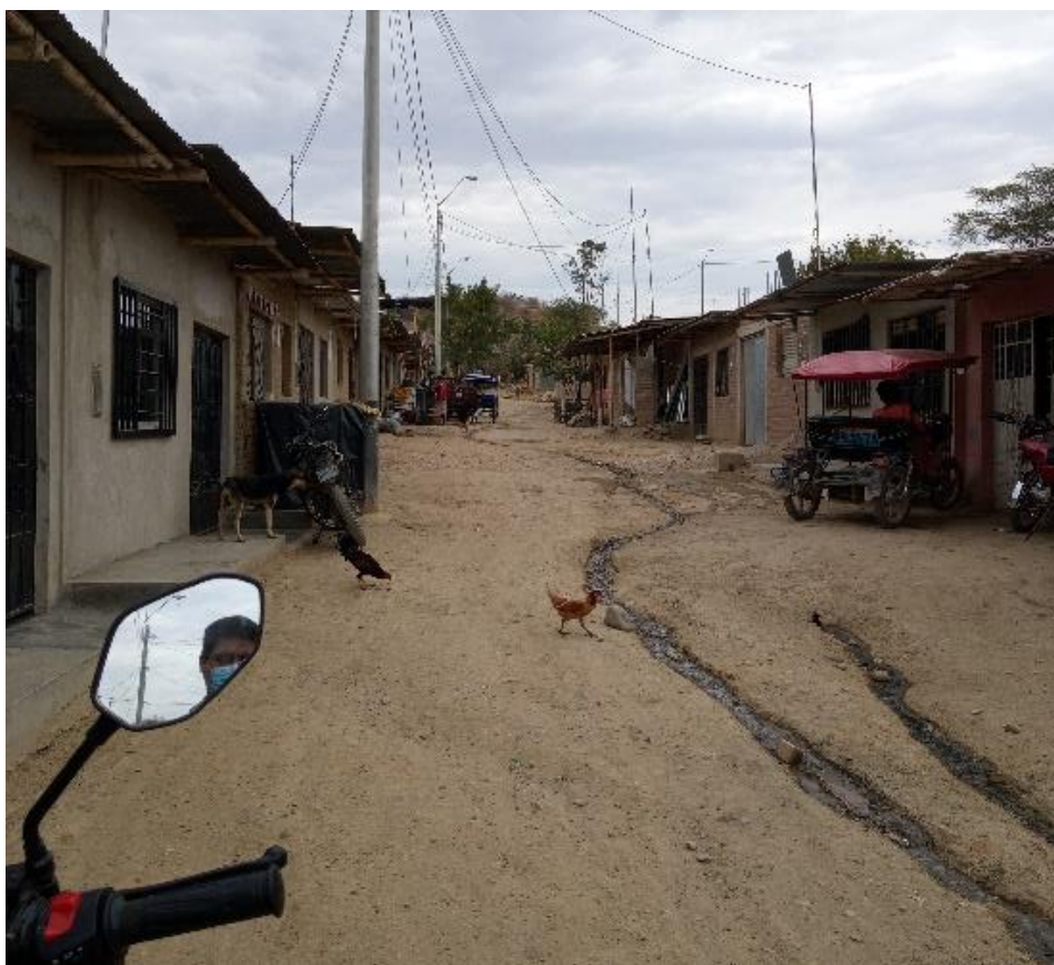
FOTO N°10: Accesibilidad al AA. HH Las Dalias mediante una vía sin pavimentar
