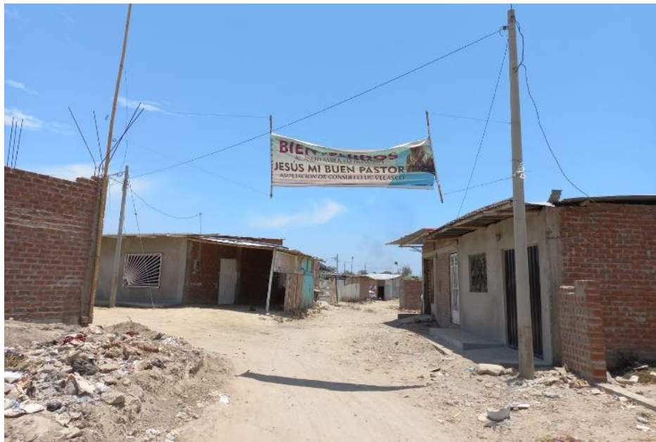
FOTO N°09: Accesibilidad al AA. HH Jesús mi buen pastor mediante una vía sin pavimentar
